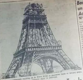
La enorme estructura metálica de la Torre Eiffel en su estado de construcción.
