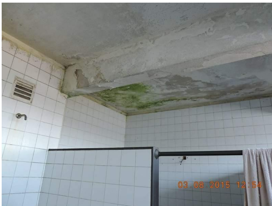
Foto 100: Filtraciones y humedades en 3° Rampa Oeste
