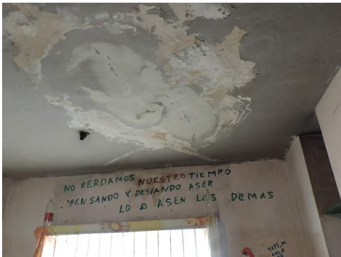
Foto 25: Humedad en el techo de una celda
