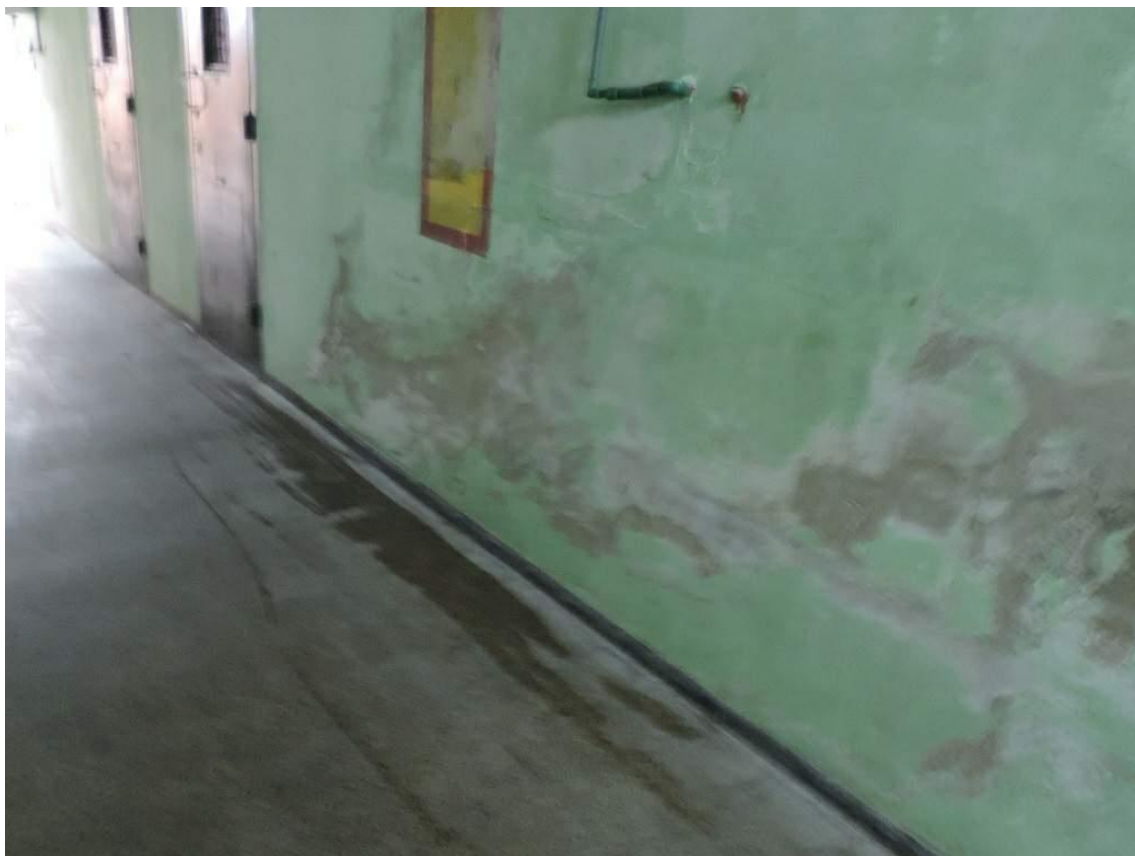
Foto 17: Humedades corredor del celdario del nivel 5
