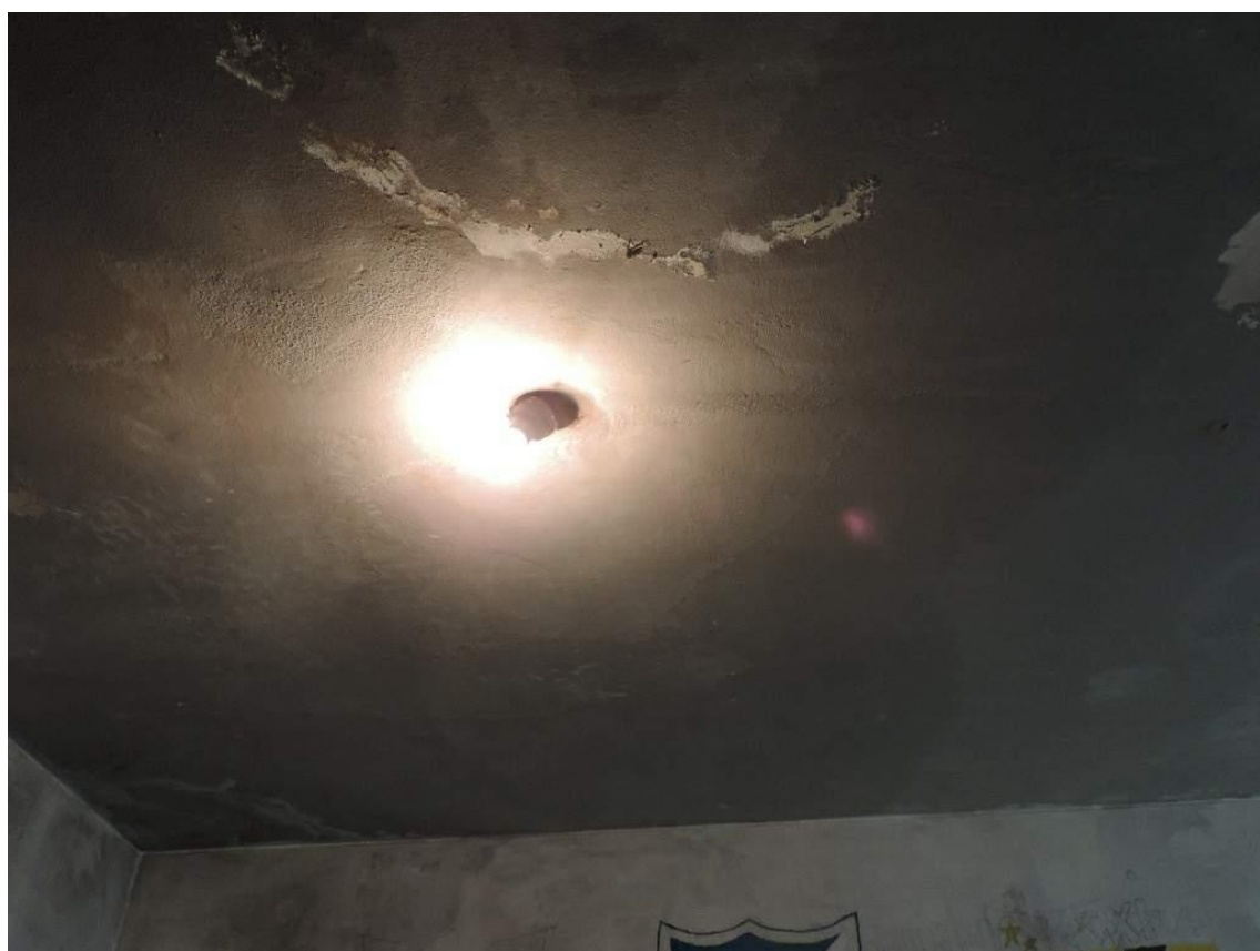
Foto 26: Filtración en el techo de una celda
