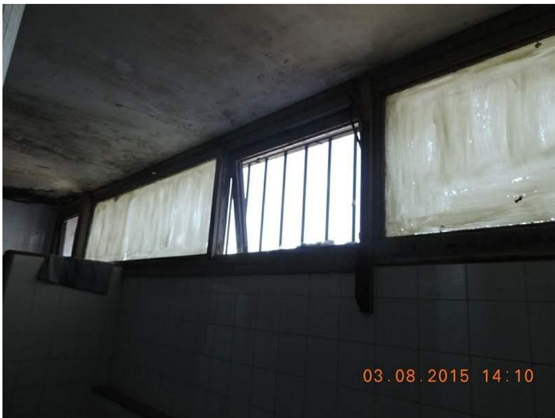
Foto 118: Estado de filtraciones y humedades en 2° Piso Oeste
