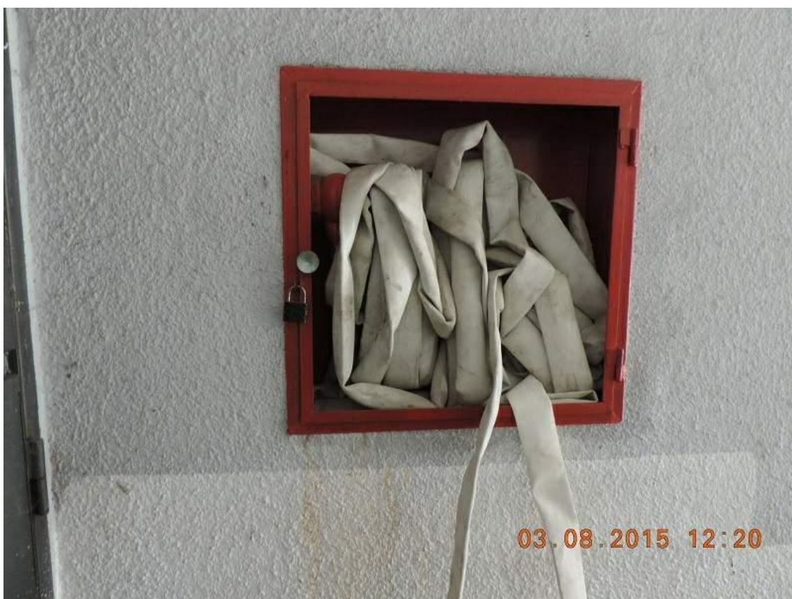
Foto 156: Estado de boca de incendio en rampa
