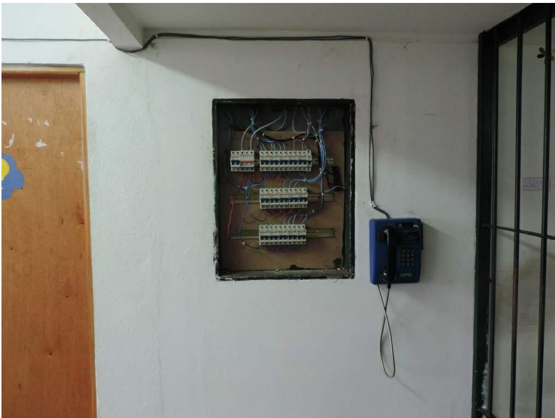
Foto 40: Tablero de registro eléctrico sin tapa al ingreso nivel 4 junto al teléfono
