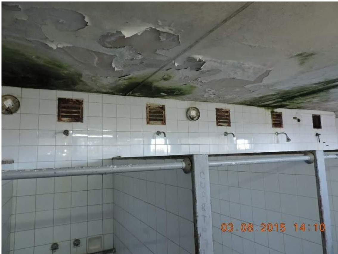
Foto 117: Estado de filtraciones y humedades en 2° Piso Oeste
