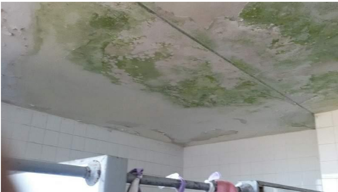
Foto 144: Filtraciones y humedades en baños del 1° Piso Este
