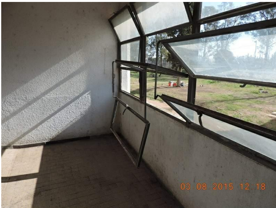
Foto 154: Estado de ventanas en descanso de rampa
