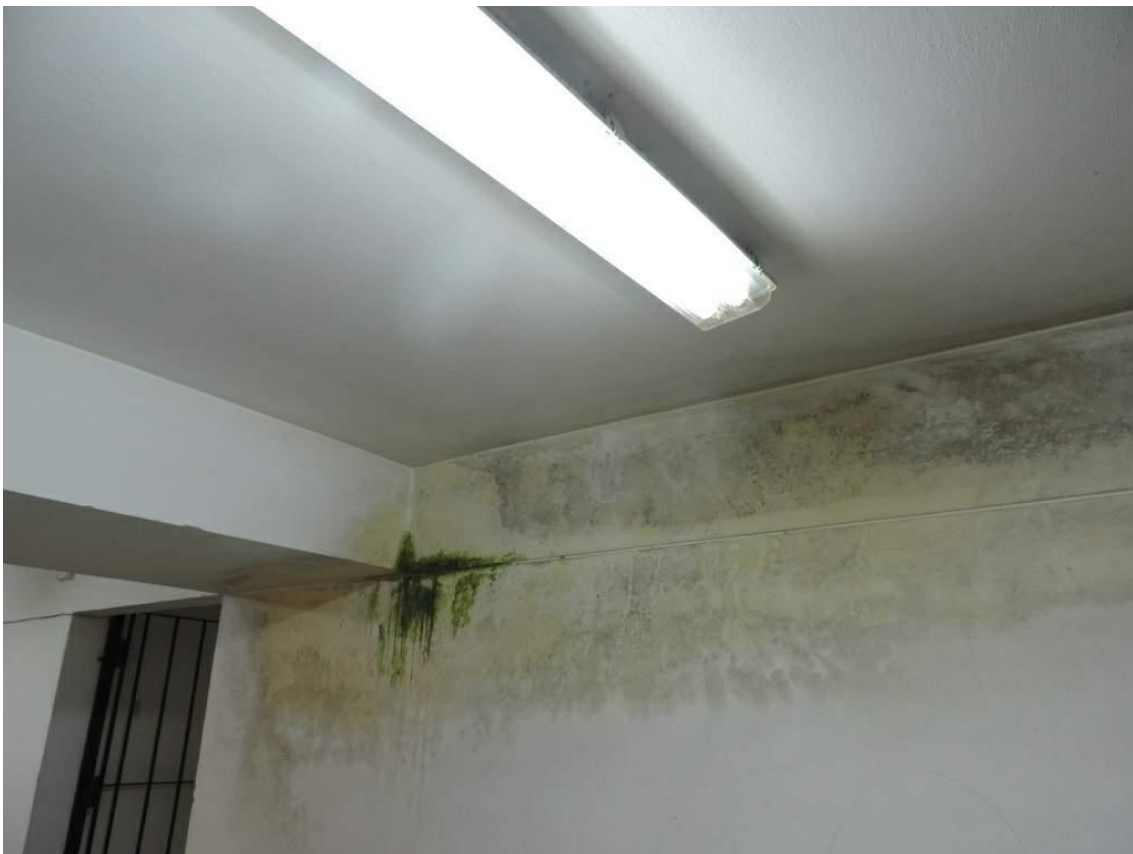
Foto 6: Humedades y filtraciones en corredor de acceso biblioteca y nivel 5
