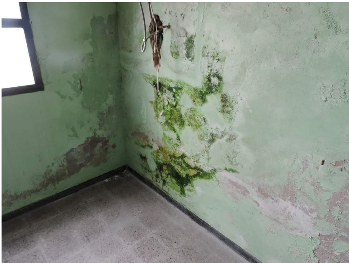
Foto 19: Humedades corredor del celdario del nivel 5
