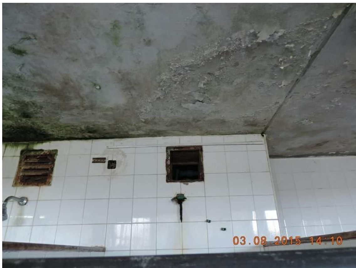
Foto 119: Estado de filtraciones y humedades en 2° Piso Oeste
