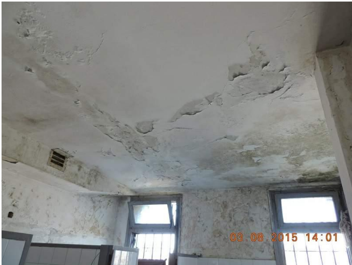
Foto 115: Estado de filtraciones y humedades en 2° Piso Oeste
