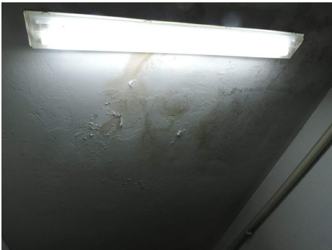
Foto 20: Filtraciones en techo corredor del celdario del nivel 5
