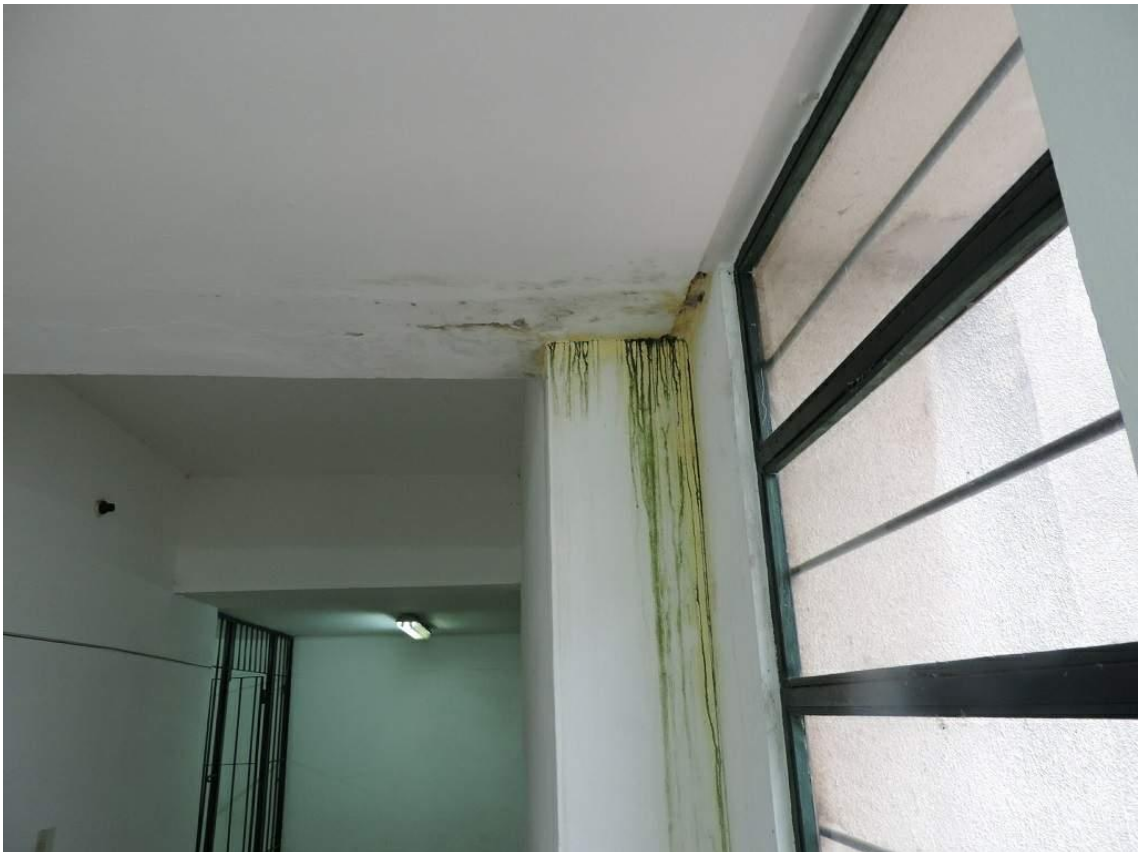
Foto 4: Filtraciones en corredor de ingreso niveles 4 y 5
