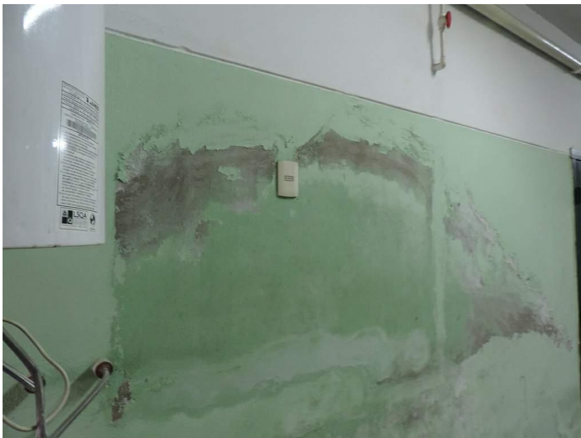
Foto 18: Humedades corredor del celdario del nivel 5
