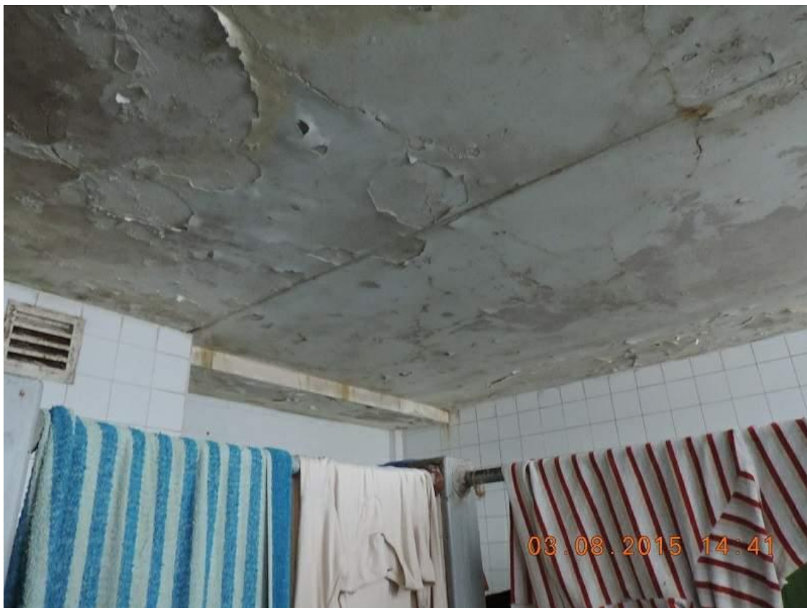
Foto 151: Filtraciones y humedades de baños de 1° Piso Primarias
