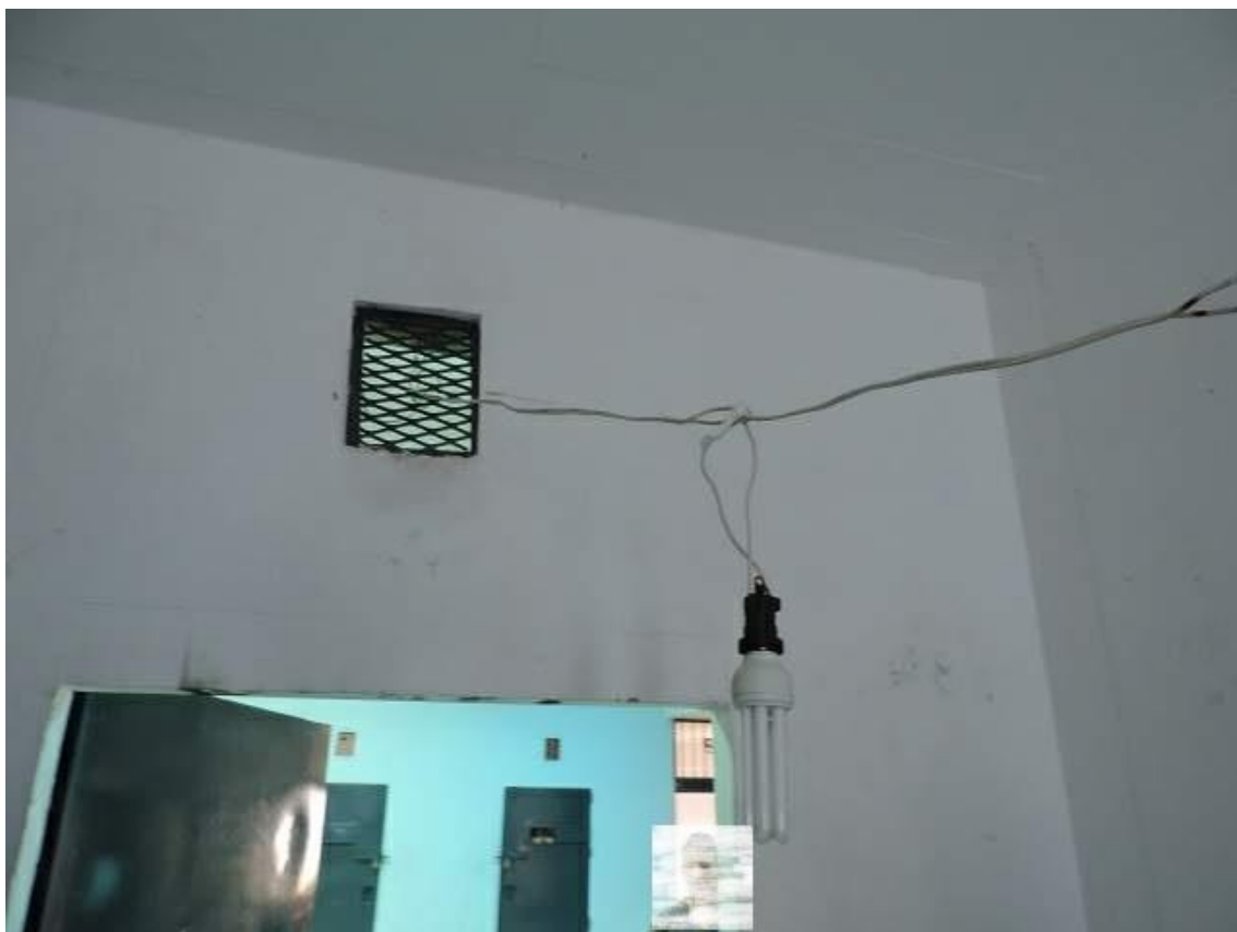
Foto 11: Instalación eléctrica precaria dentro de las celdas.
