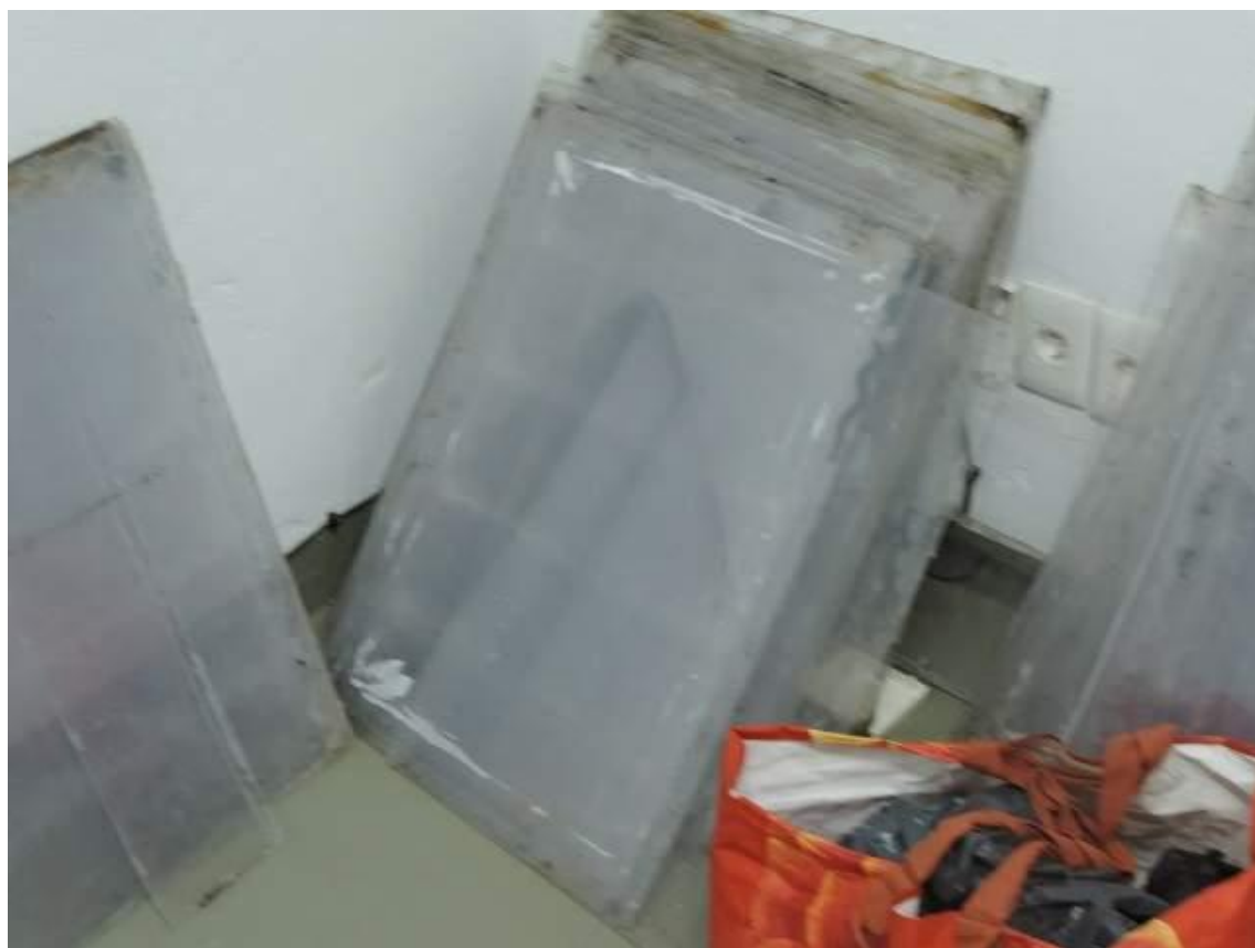
Foto 6: Policarbonatos despegados.
