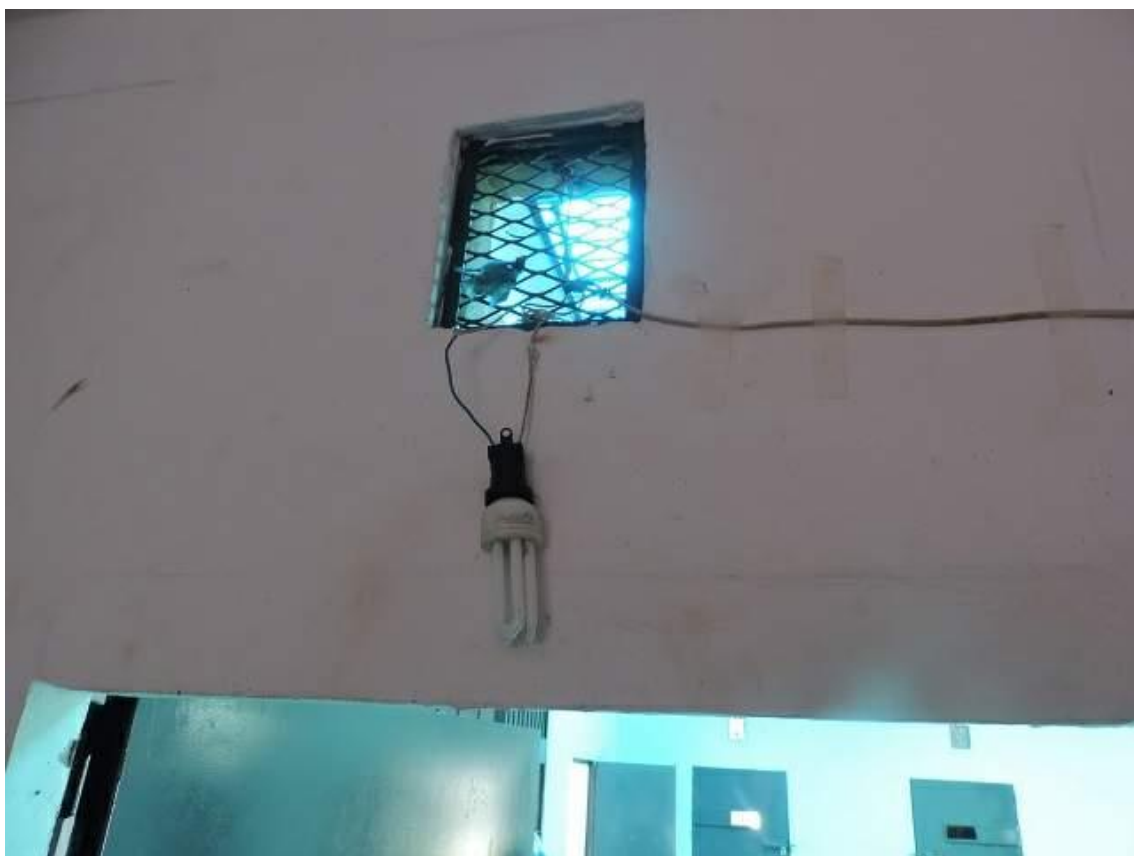
Foto 12: Instalación eléctrica precaria dentro de las celdas.
