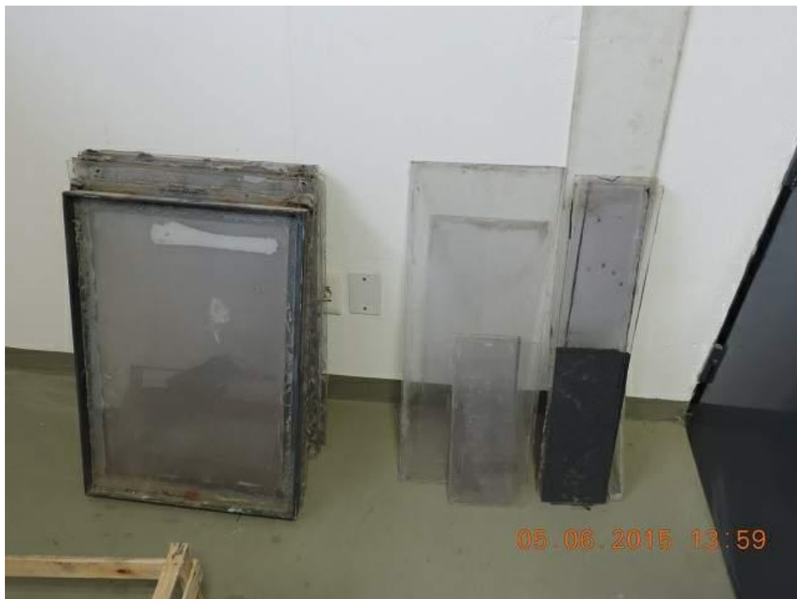
Foto 5: Policarbonatos despegados.
