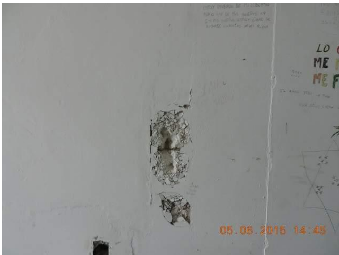
Foto 7: Revoques desprendidos en celdas.
