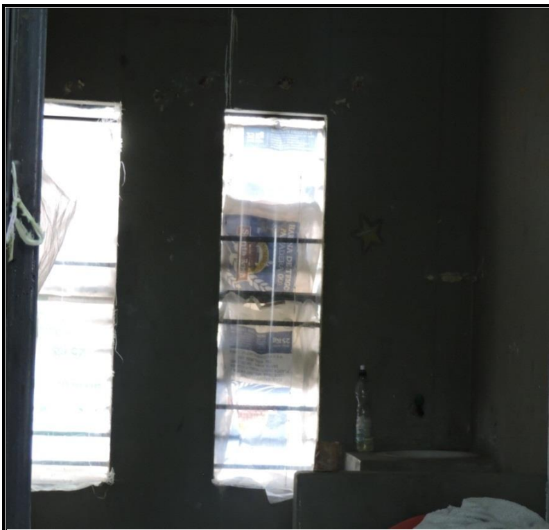
Foto 10. Ventanas. Celda - Sector D. Registro Fotográfico 6 de setiembre de 2019.
