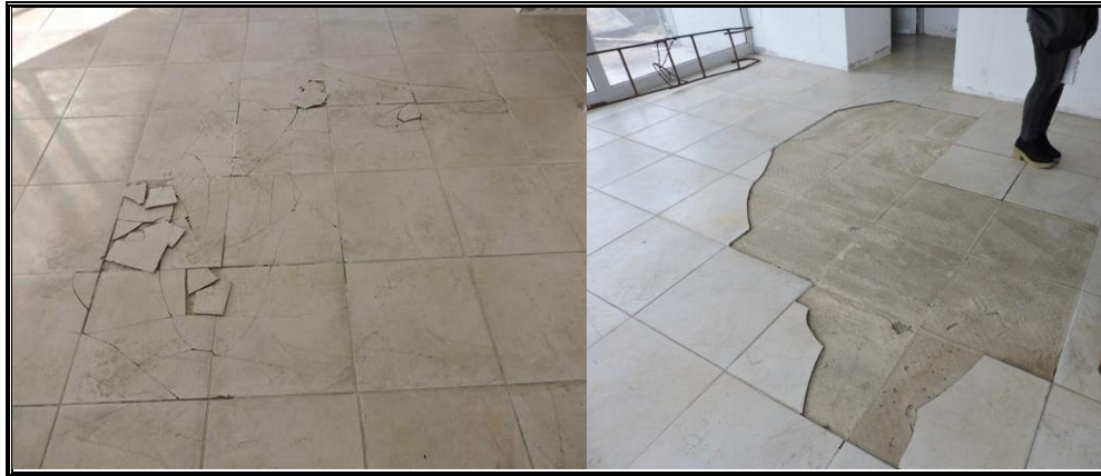
Foto 1. Registro Fotográfico 20 de abril de 2016
