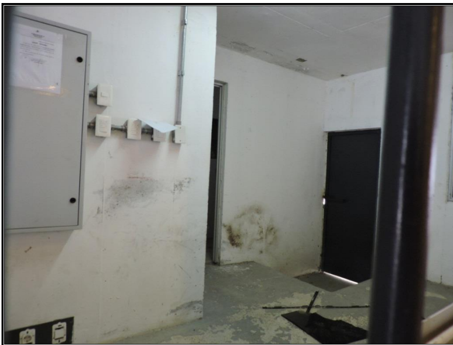
Foto 4. Instalaciones comunes al Módulo 12. Registro Fotográfico 6 de setiembre de 2019
