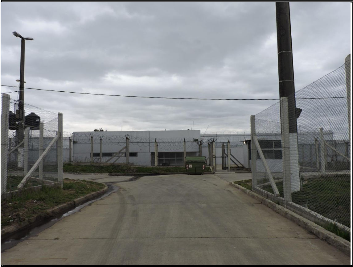
Foto 1. Unidad N° 4 – Acceso al Módulo 12
