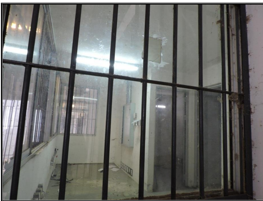
Foto 5. Instalaciones comunes al Módulo 12. Registro Fotográfico 6 de setiembre de 2019
