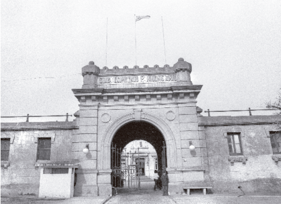
Cárcel de Punta Carretas. Año: 1985 (aprox.). Sin autor..
