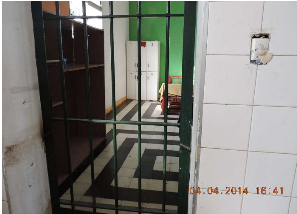
Foto 9: reja entre baños y celda
