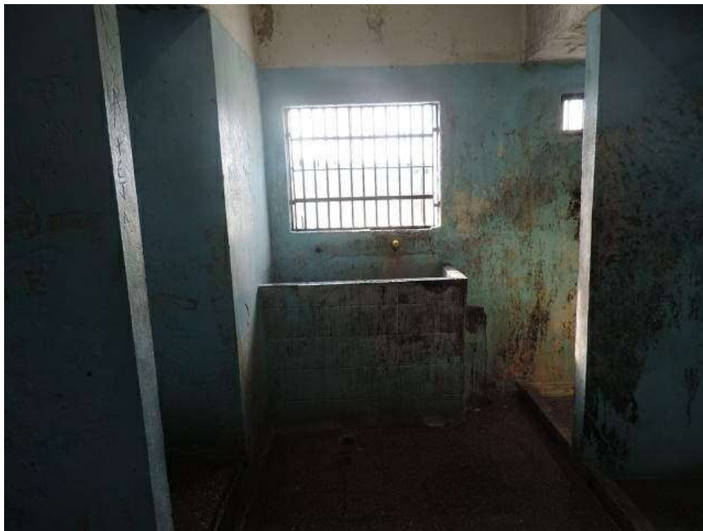
Foto 23: Vista general del baño.
