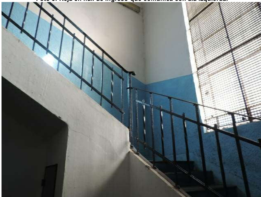
Foto 4: Escalera de acceso al celdario.
