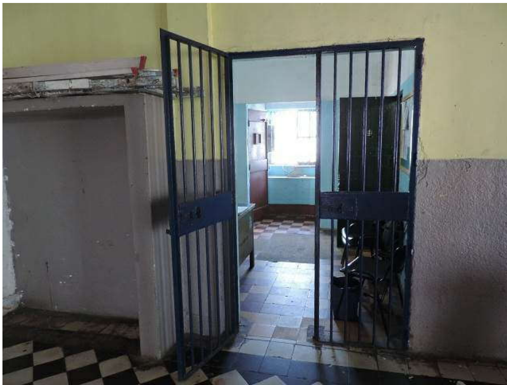
Foto 37: Reja del hall de ingreso que comunica con el ala derecha.
