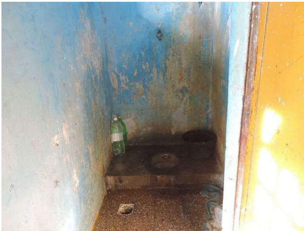
Foto 19: Sanitario dentro de la celda.
