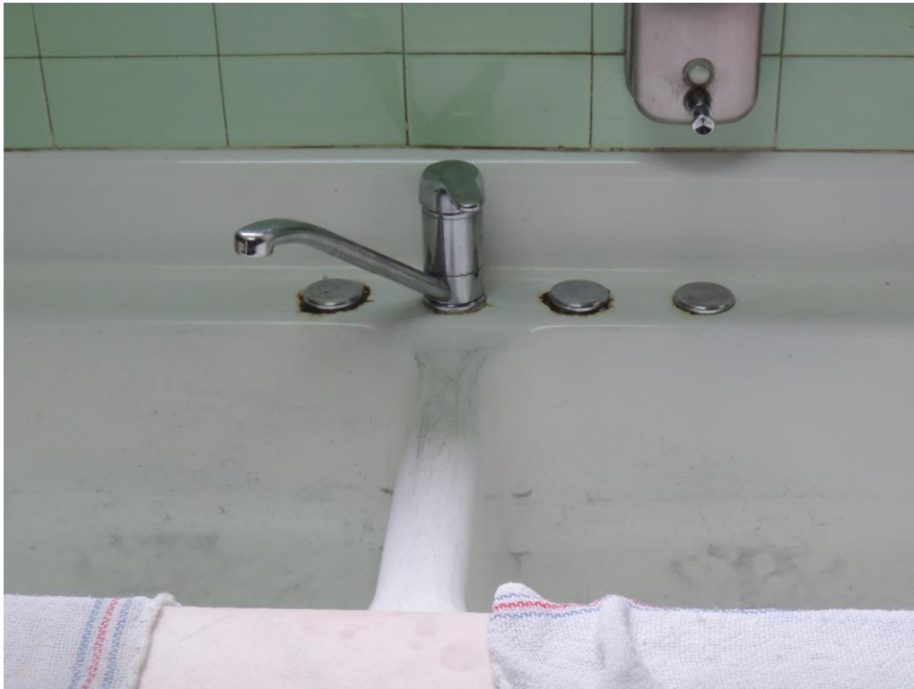
Foto 29: Instalaciones de la cocina.
