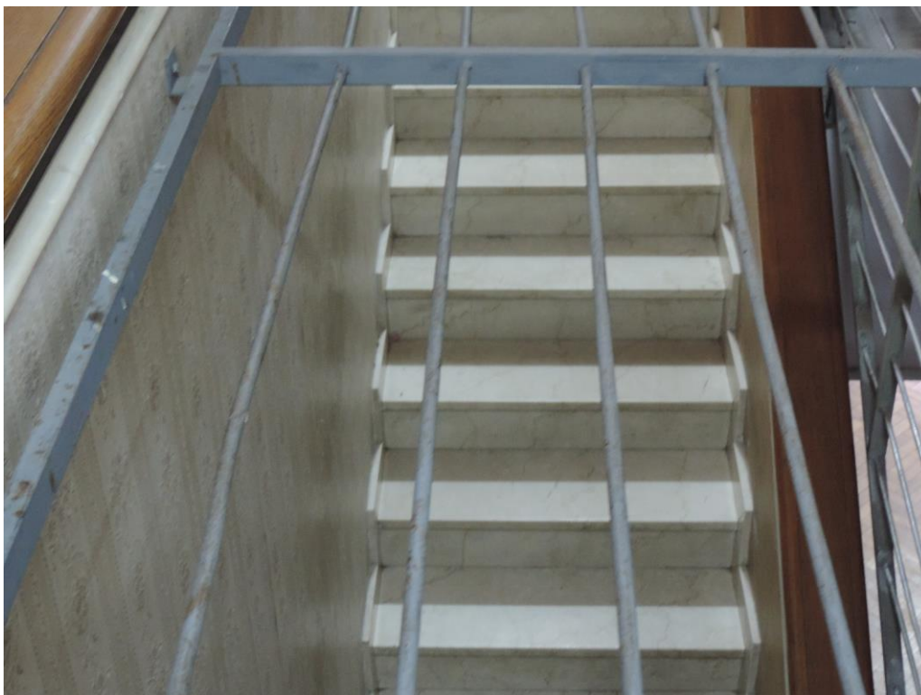
Foto 8: Escalera de acceso a dormitorio de adolescentes mujeres.
