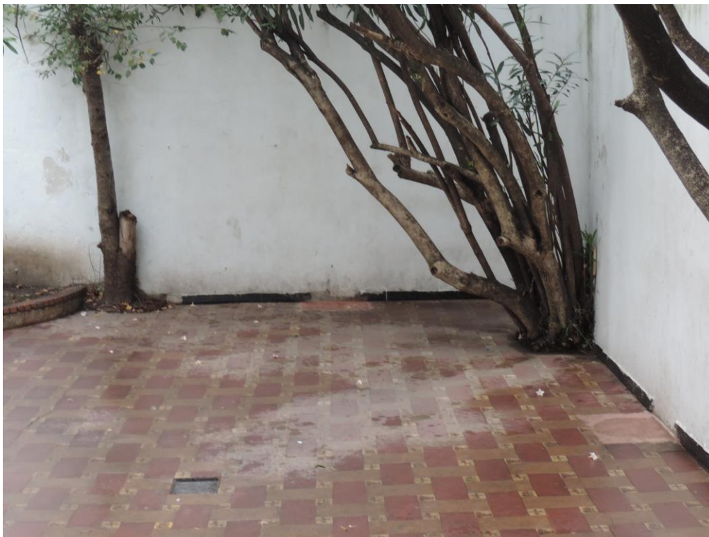
Foto 32: Vista del patio interior.
