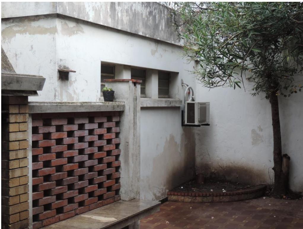
Foto 34: Vista del patio interior.
