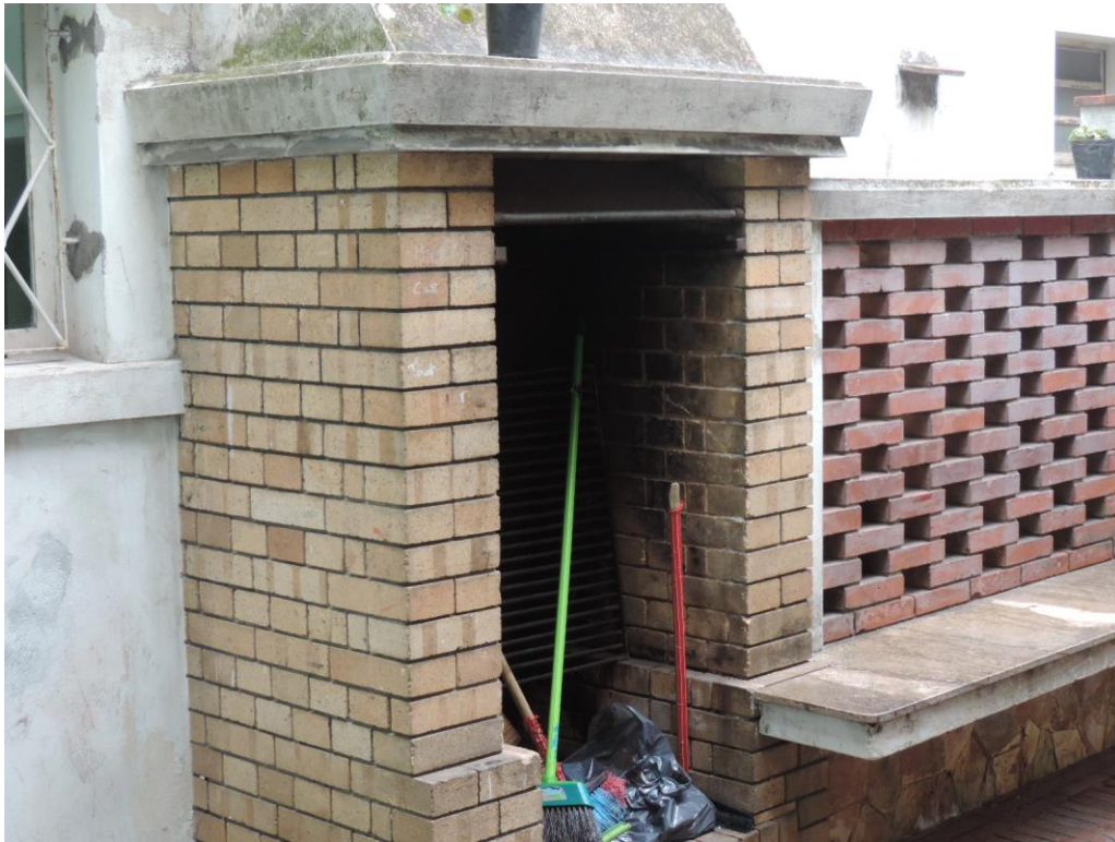
Foto 33: Vista del patio interior.
