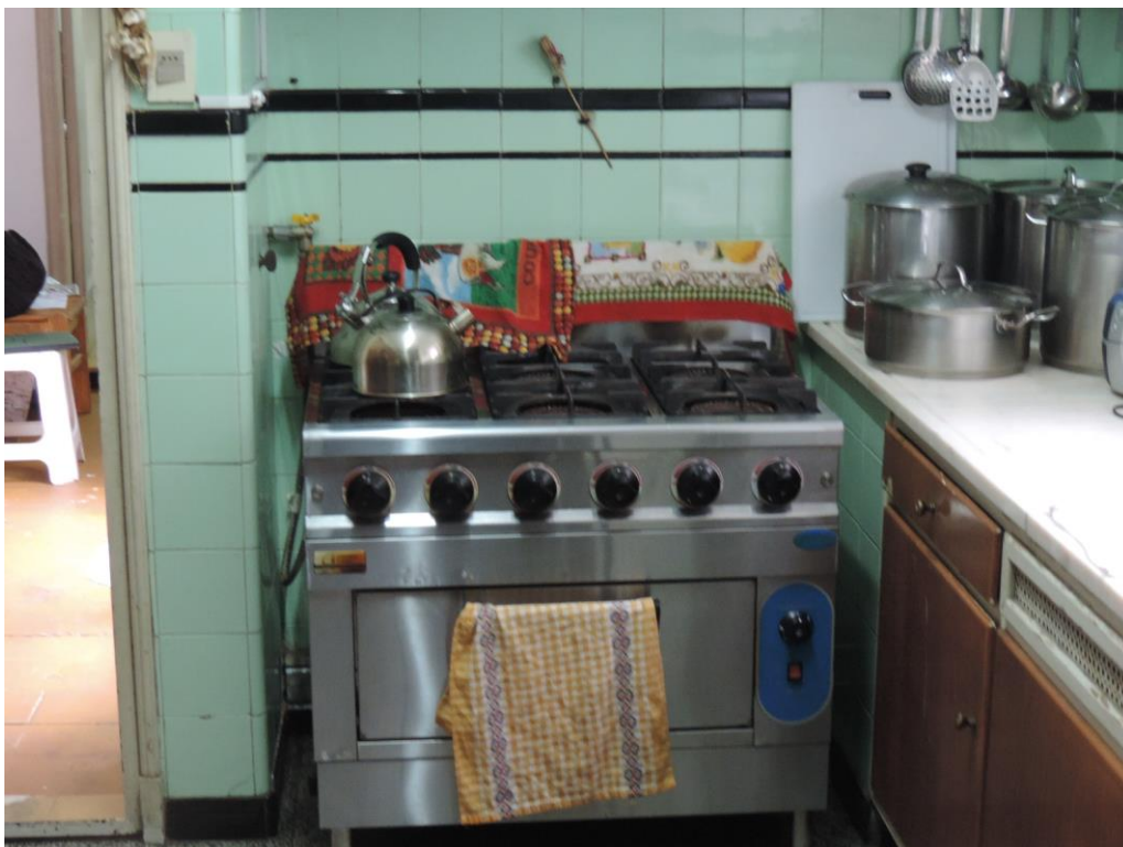
Foto 28: Instalaciones de la cocina.
