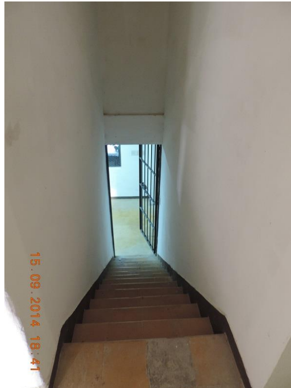
Foto 27: escaleras a planta alta
