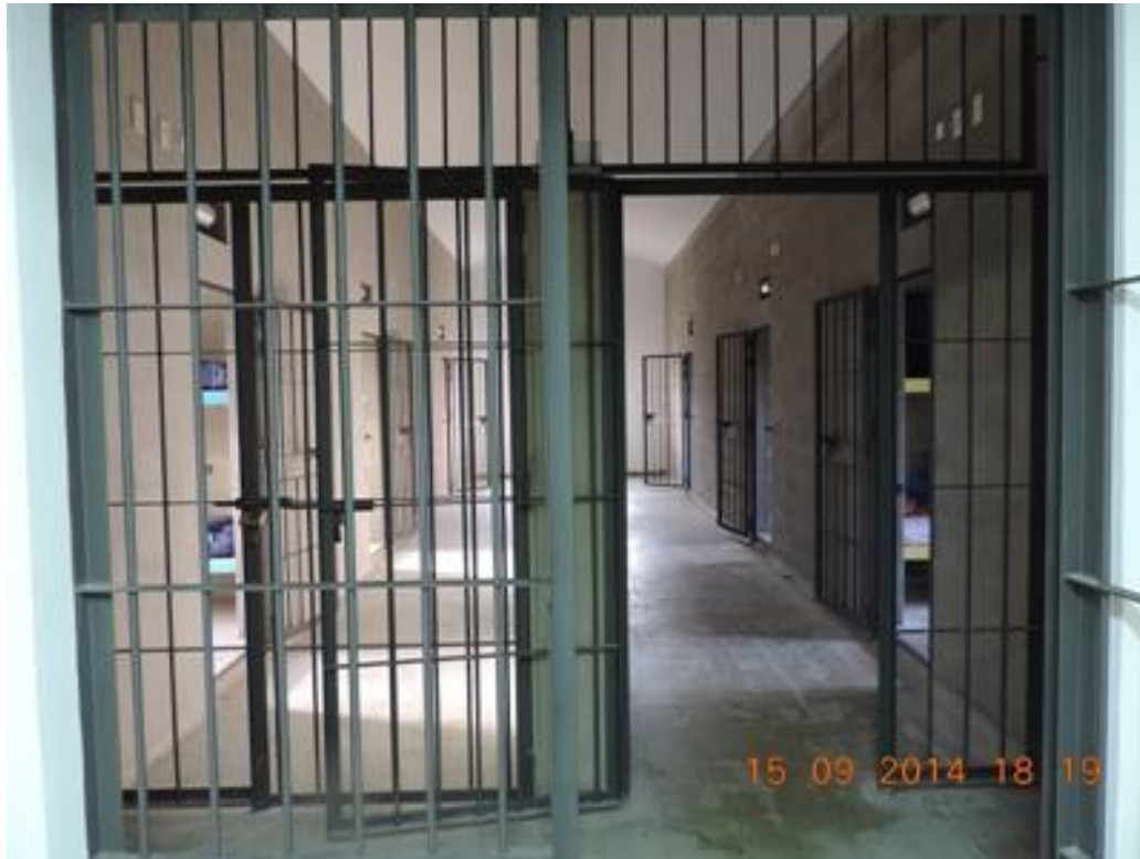
Foto 21: entrada al celdario
