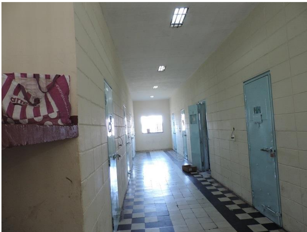
Foto 11: pasillo del celdario
