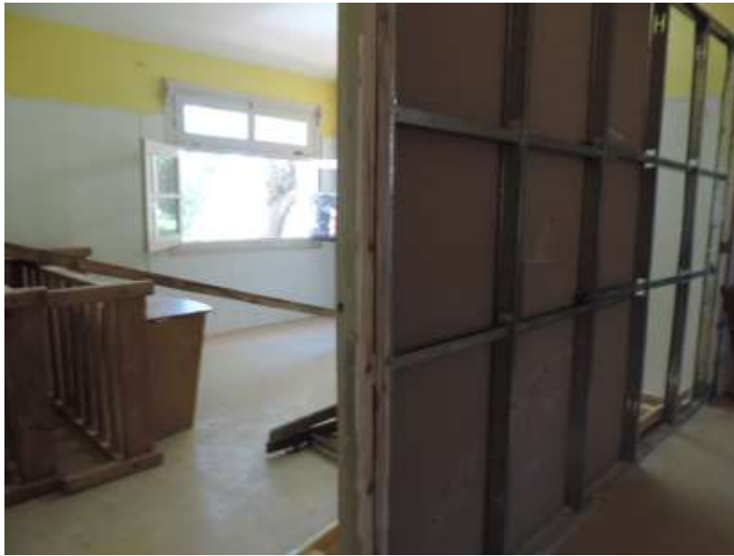
Foto 36: Espacio en construcción
