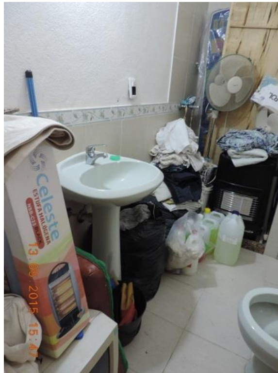
Foto 13: Baño de los funcionarios
