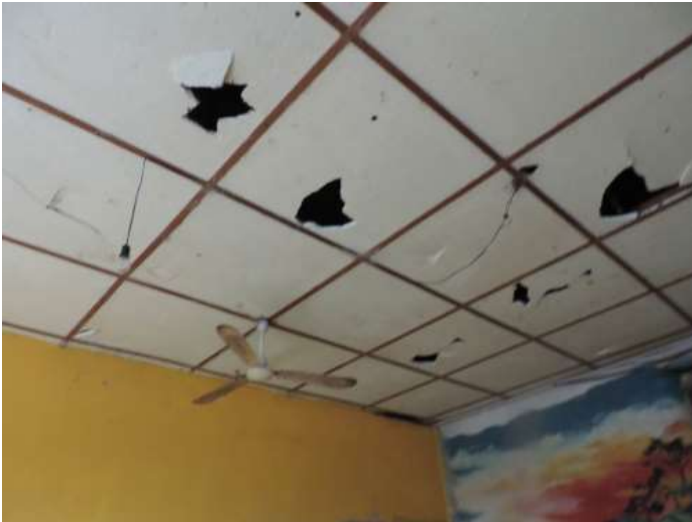
Foto 13: Techo Comedor/sala de usos múltiples
