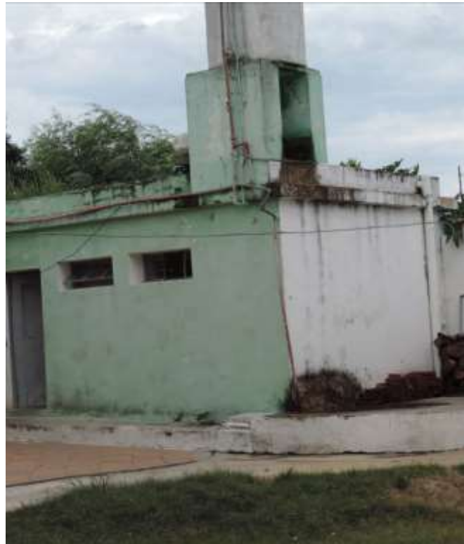
Foto 9 : Tanque de agua
