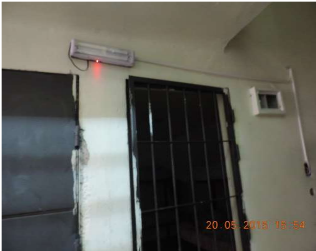
Foto nº 7: cuarto de contención por fuera
