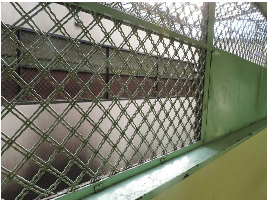
Foto 3: Celdario 6to piso
