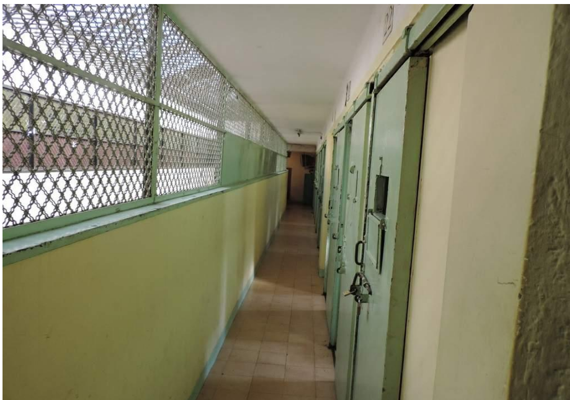
Foto 1: Celdario 6to piso
