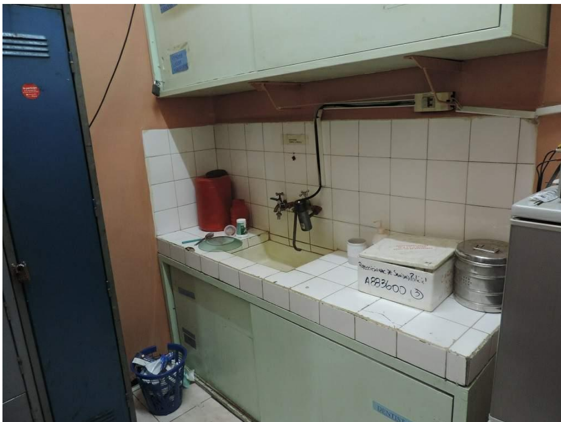
Foto 42: Instalaciones de enfermería central
