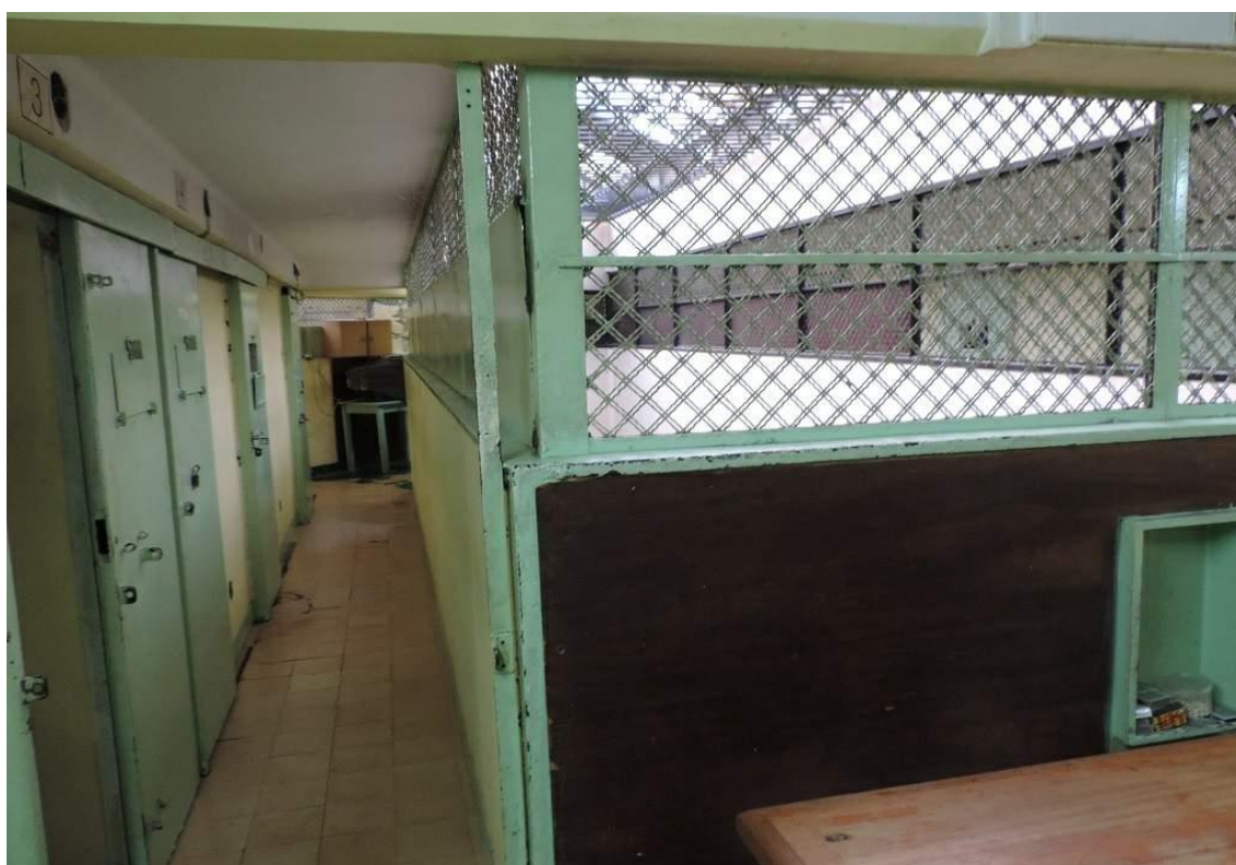
Foto 2: Celdario 6to piso
