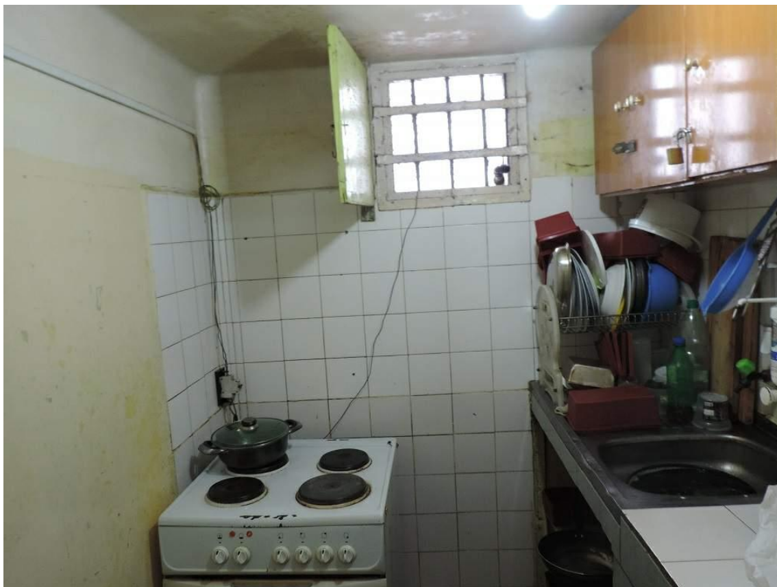
Foto 6: Cocina 6to piso "A"
