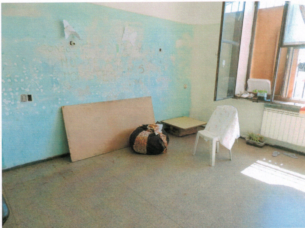
Foto 6 – Vista de celda, proceso de traslado de mujeres de Piso 2 Oeste
