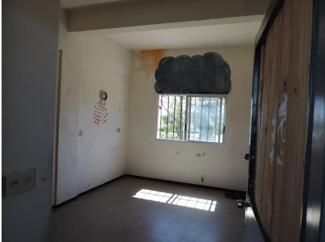
Foto 7– Vista de celda desalojada, en buenas condiciones de mantenimiento, Piso 2 Oeste
