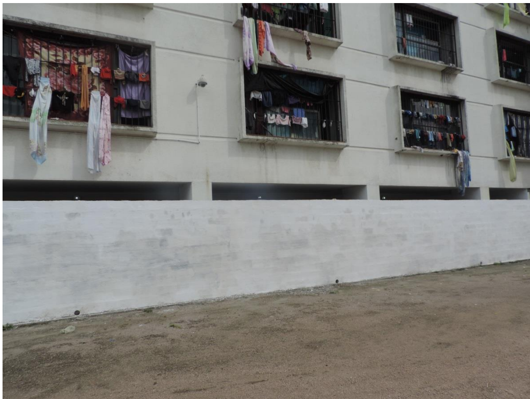
Foto 5 – Vista exterior de Piso1 y 2 Oeste
