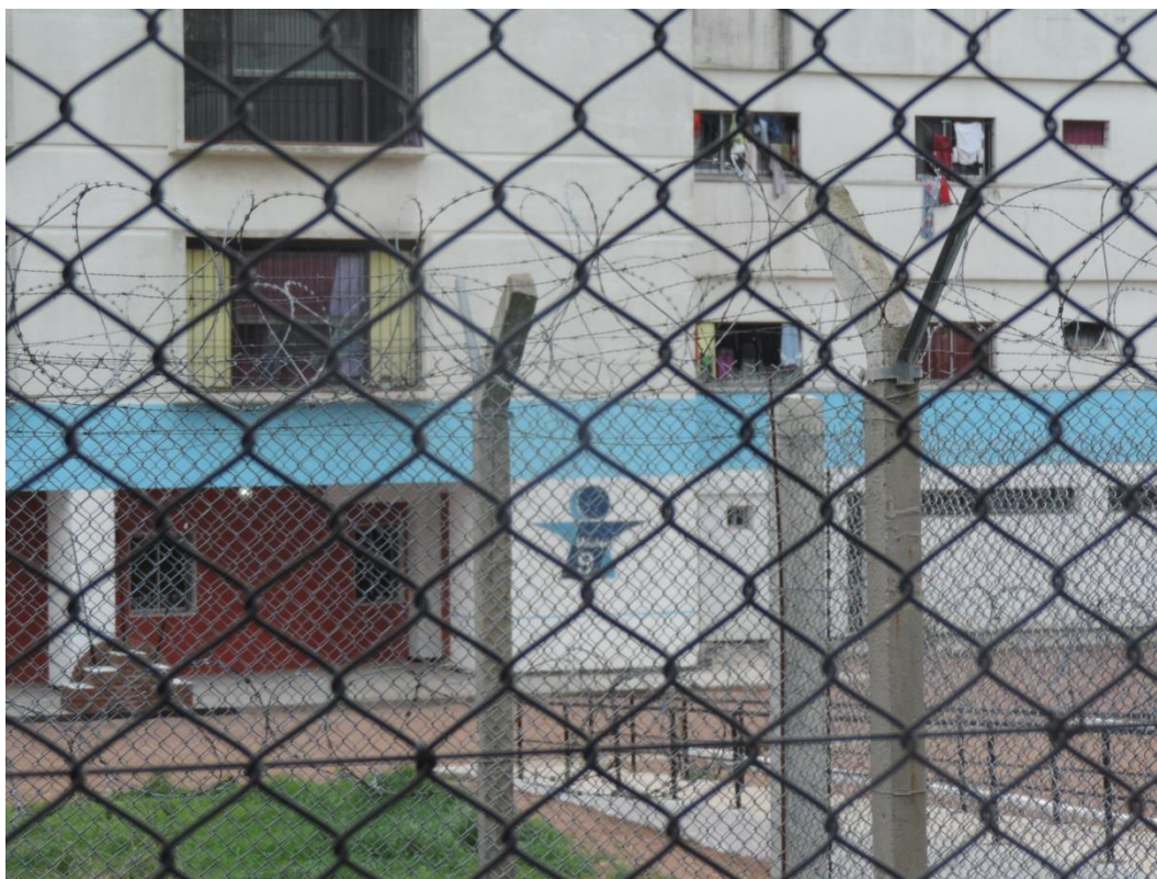
Foto 4– Vista exterior de ingreso a Unidad 9, ventanas de piso 1 y 2 Oeste
