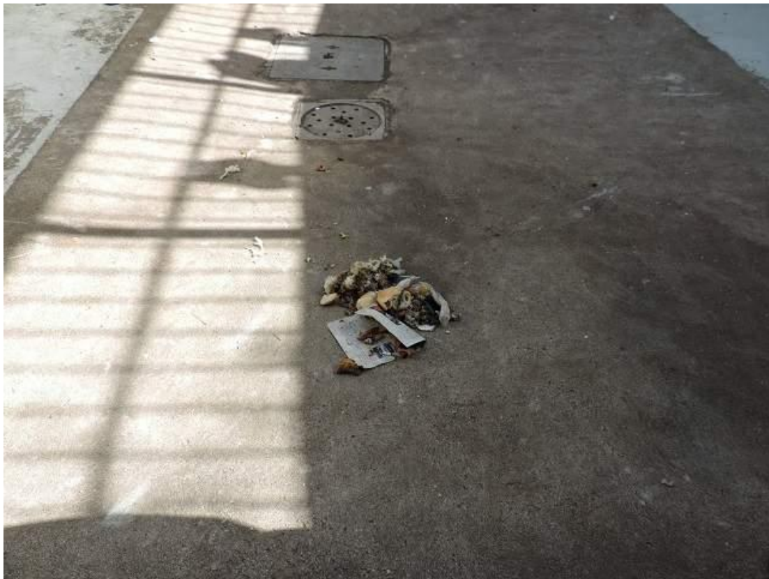
Foto 4: Patio interior de otro de los módulos
