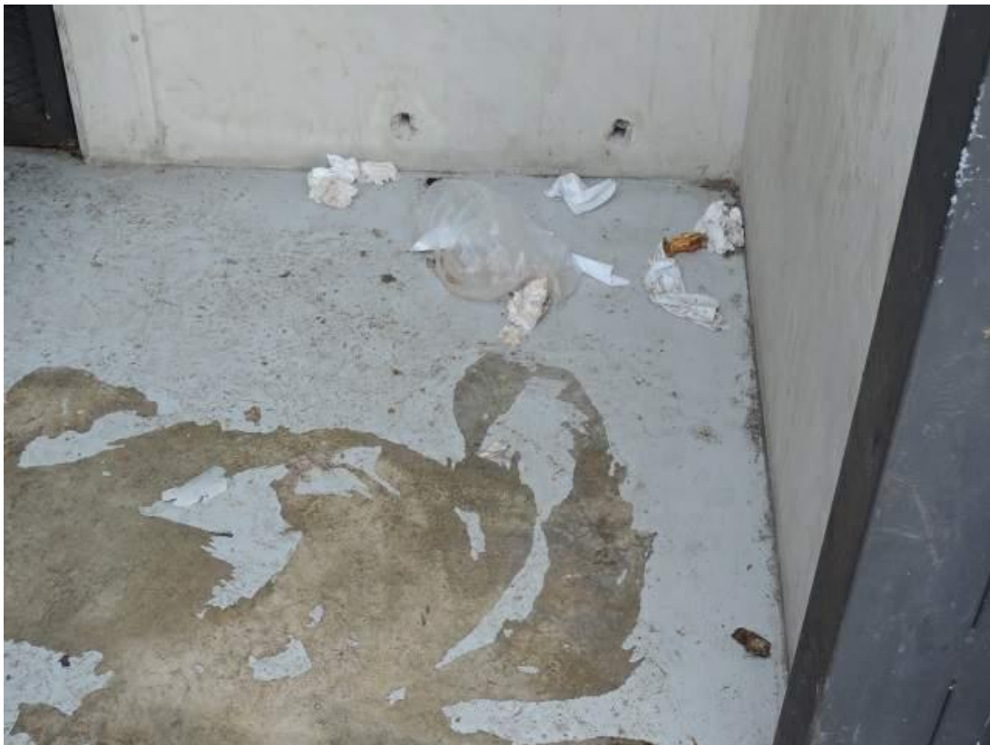
Foto 6: Patio interior de otro de los módulos
