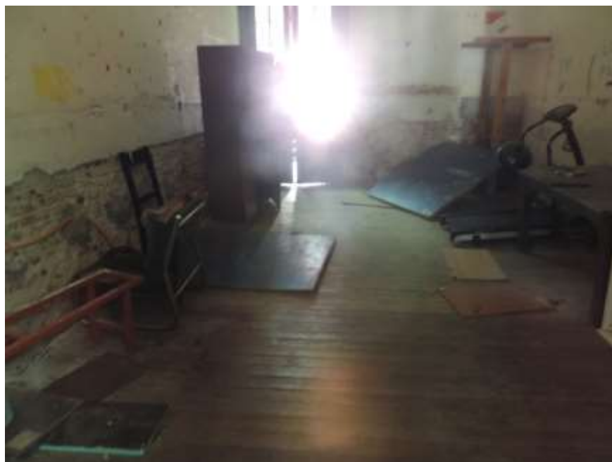
Foto N° 9: sala de recreación en espera de reformas
