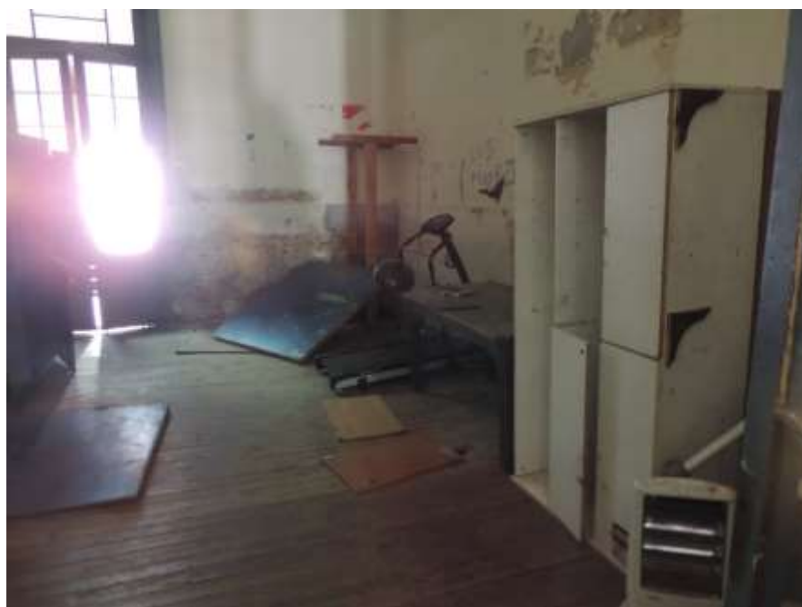
Foto N° 10: Sala de recreación en espera de reformas
