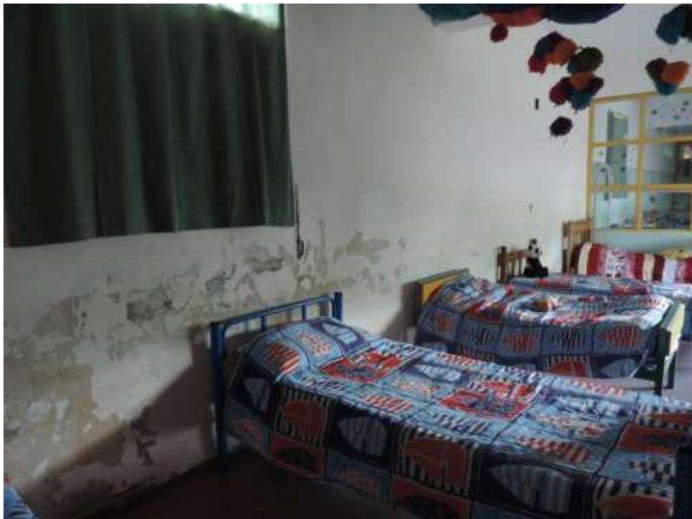
Foto N° 6: Deterioro en las paredes de la sala de NNA grandes
