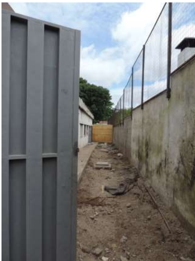
Foto 19: Sector lateral en reparación (Noviembre de 2017)
