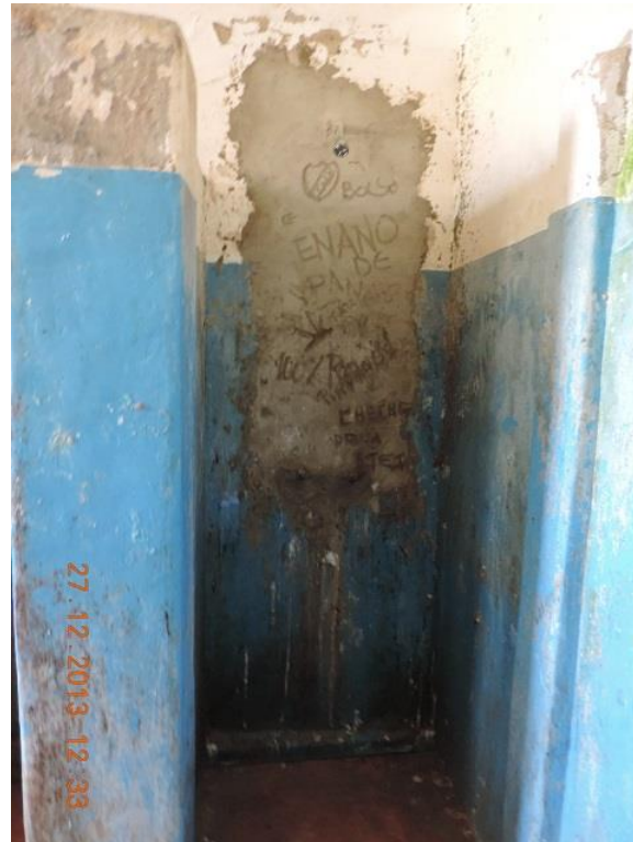
Foto 56: Detalle batería de baños
