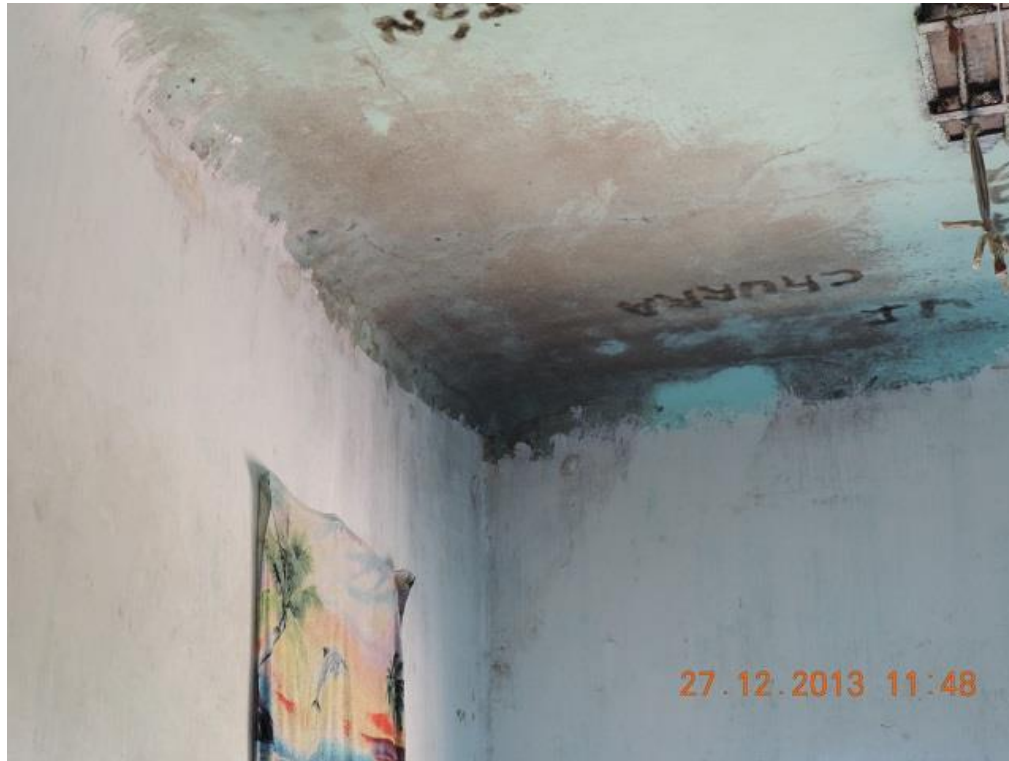
Foto 52: Detalle interior de las celdas
