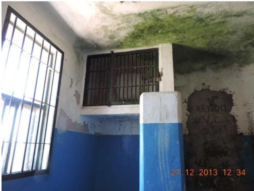
Foto 57: Detalle batería de baños
