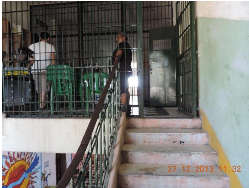
Foto 42: Escalera de acceso al celdario, reja de ingreso
