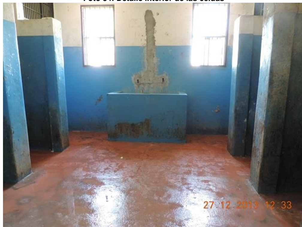
Foto 55: Detalle batería de baños
