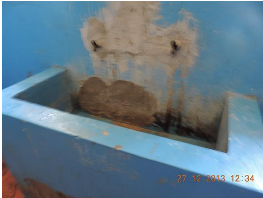
Foto 58: Detalle batería de baños
