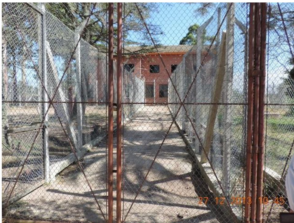
Foto 2: Galería de acceso.
