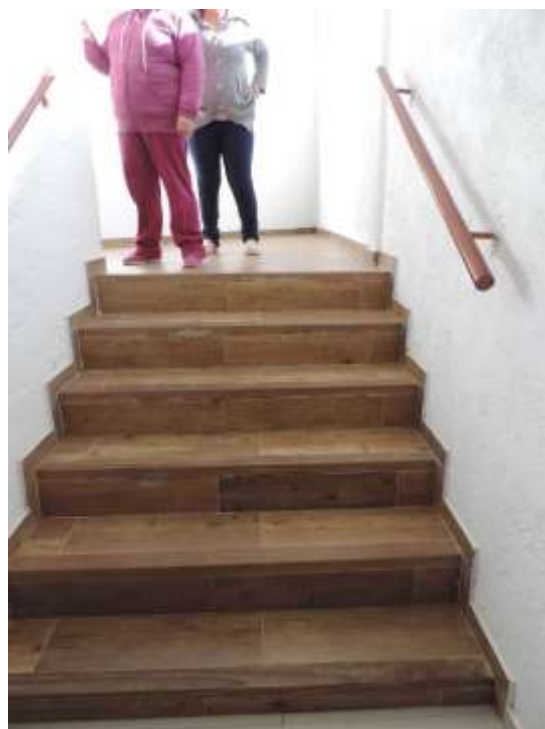
Foto 4: Escalera a la planta alta
