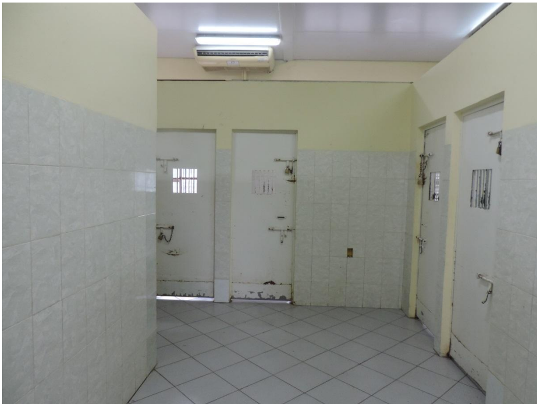
Foto 7: Cuartos de contención, piso 2.
