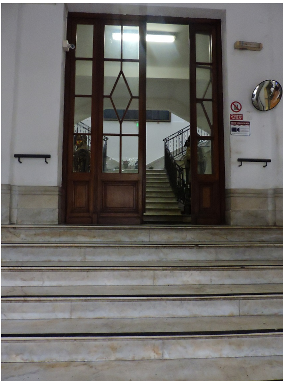
Foto 2: Escaleras de ingreso al Centro "Pequeño Cottolengo Don Orione Masculino"
