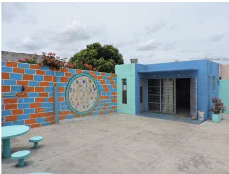
Foto 4: Entrada a celdas.
