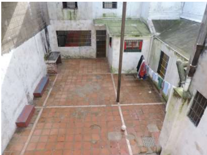
Foto 2: Vista patio interior
