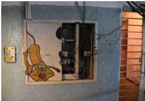
Imagen 4. Tablero en el sector 1º Oeste (agosto 2023)
