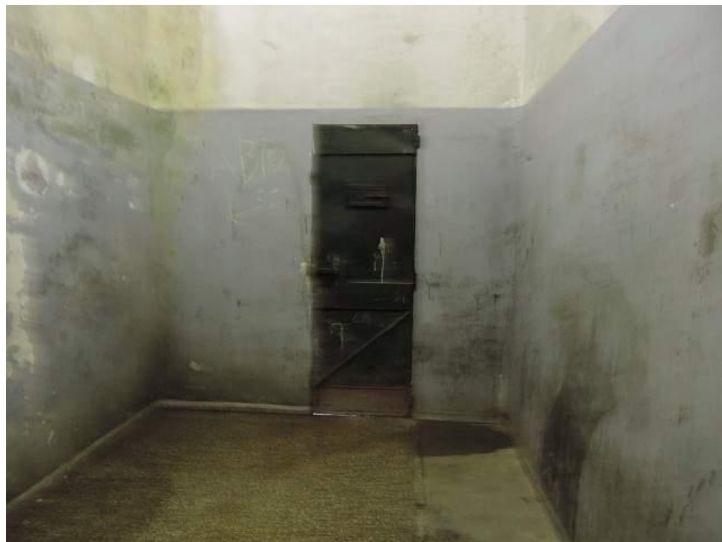
Foto 14: Distribuidor de área de baños
