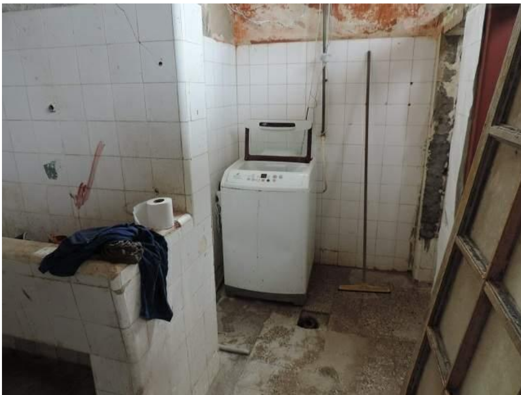
Foto 26: Baños del gimnasio
