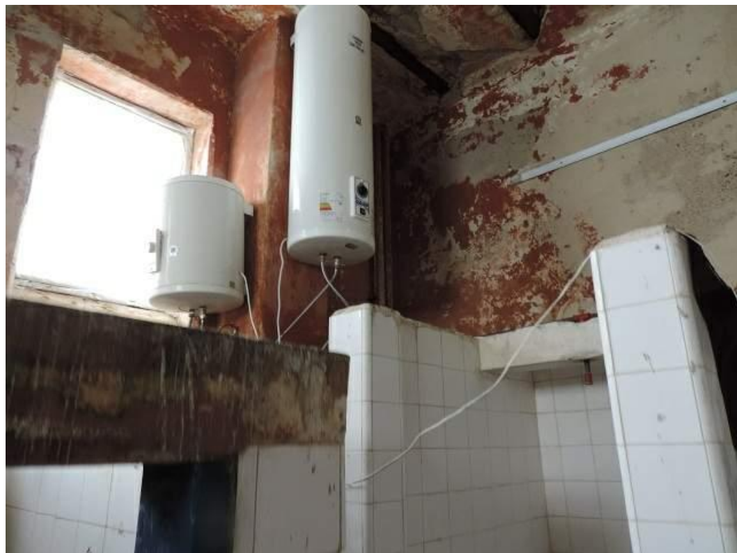
Foto 28: Baños del gimnasio
