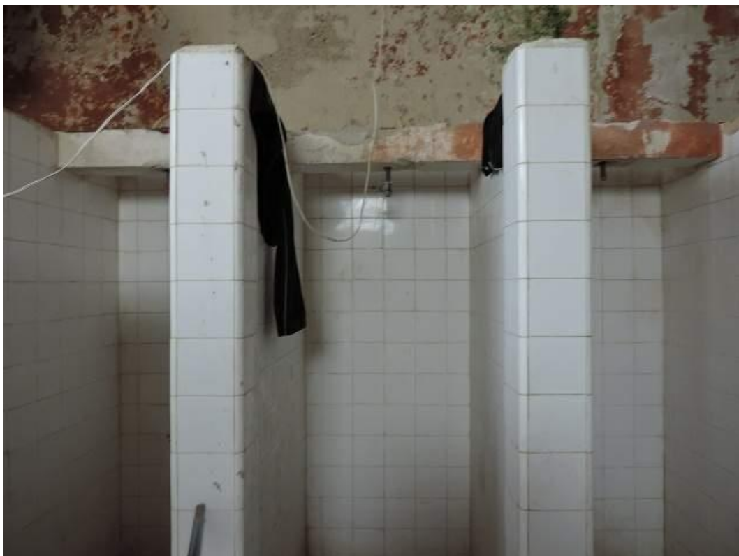
Foto 27: Baños del gimnasio
