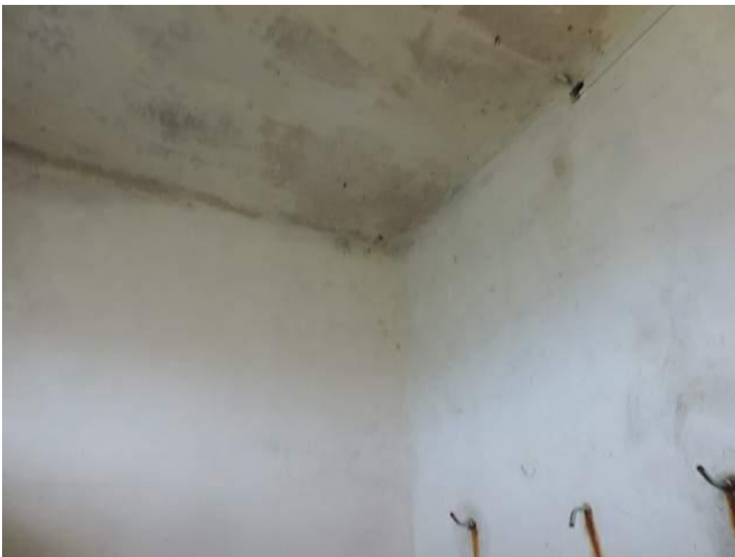
Foto 18: Techos de baños
