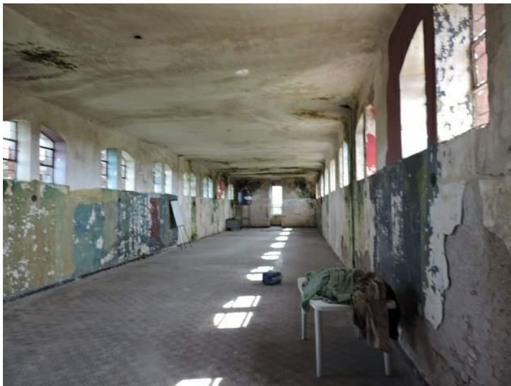
Foto 59: Estado del 2do piso
