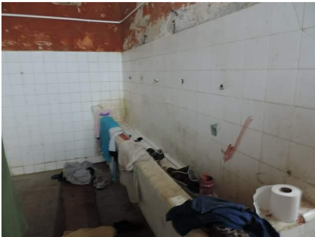
Foto 25: Baños del gimnasio
