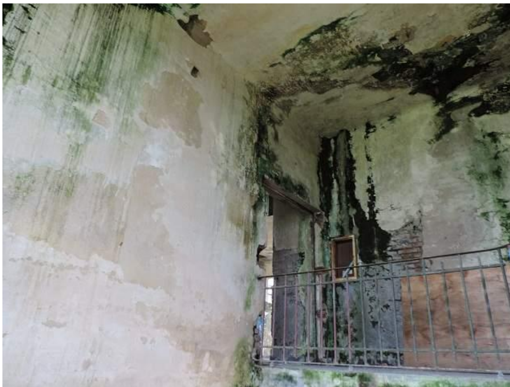
Foto 60: Estado del 2do piso
