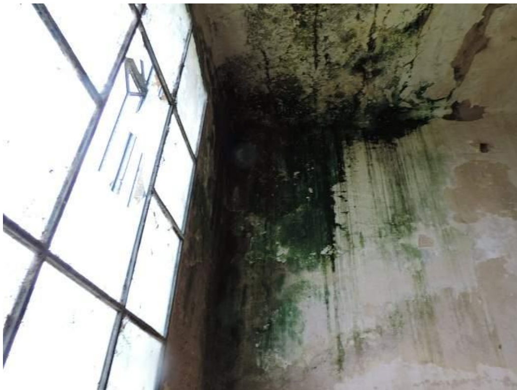
Foto 61: Estado del 2do piso
