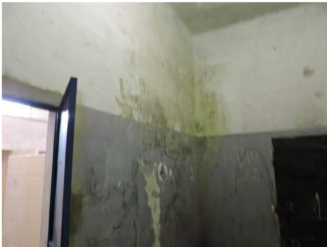
Foto 13: Distribuidor de área de baños
