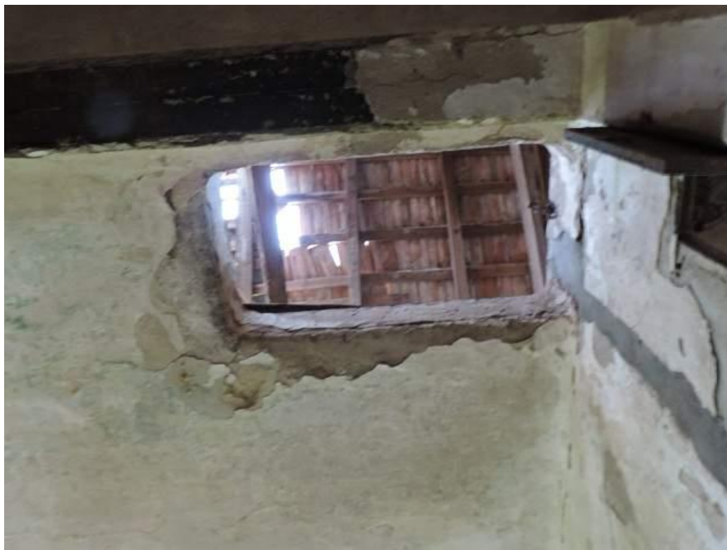
Foto 62: Estado del 2do piso
