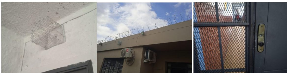
Foto 1, 2 y 3: utilización de rejillas industriales y serpentina de alambre, propias de un centro de privación de libertad.
