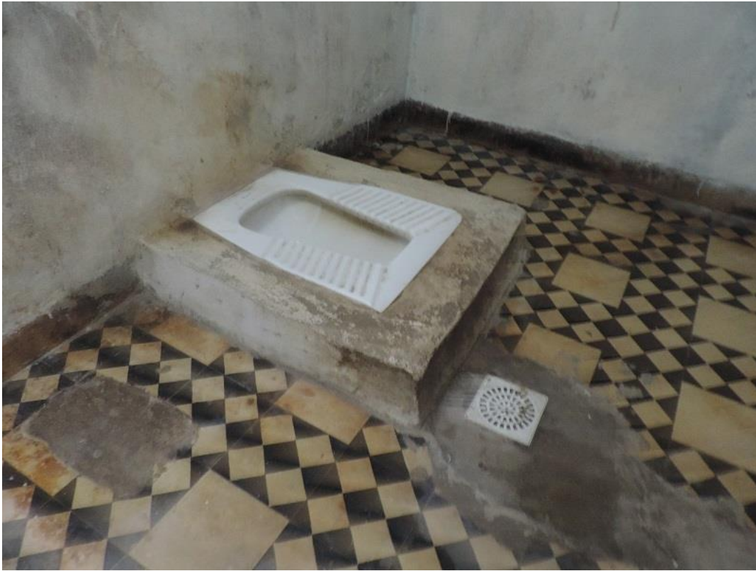
Foto 11-Baño de la celda de ingreso, planta alta
