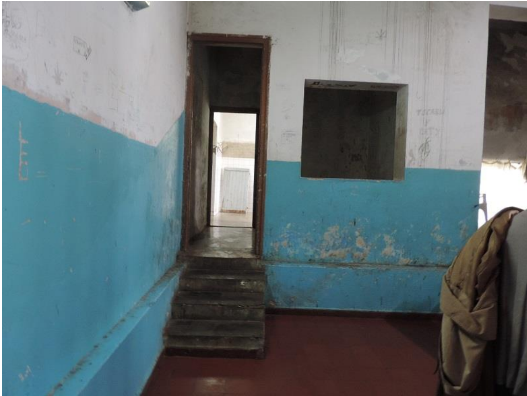
Foto 15-Ingreso al baño planta baja
