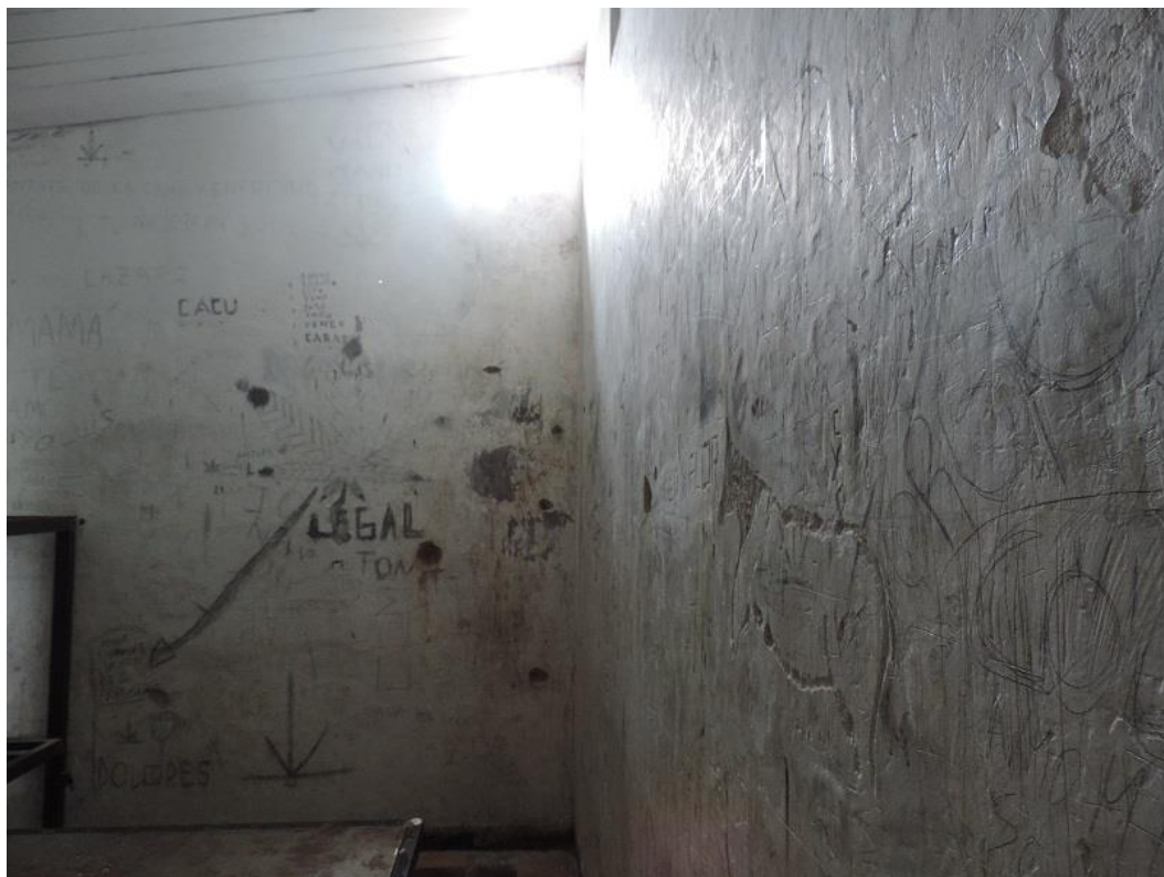
Foto 10-Celda de ingreso, planta alta
