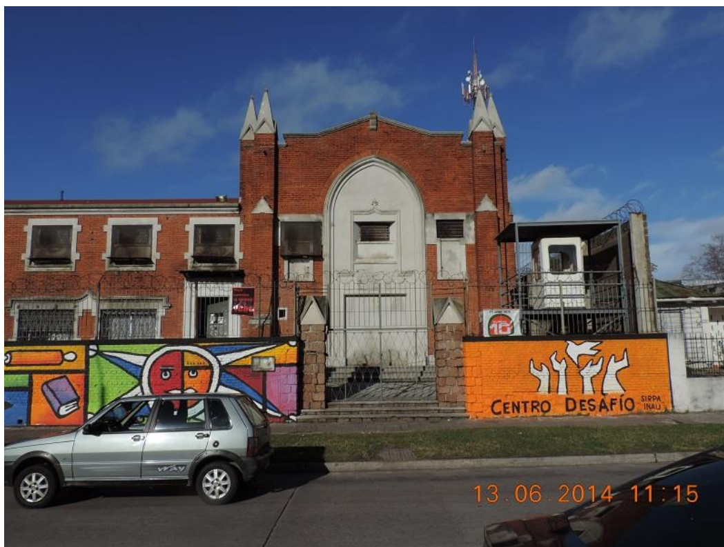
Foto 3: frente del Centro
