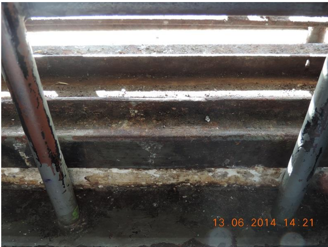
Foto 12: rejas en la ventana de celda
