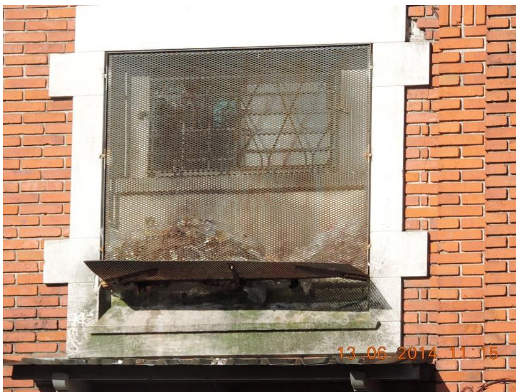
Foto 4: ventana celda desde el exterior
