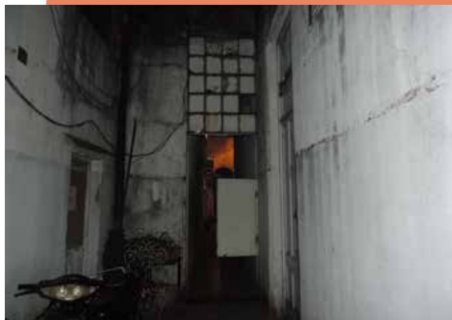
+Acceso a calabozos. Seccional N° 15. Montevideo. Registro fotográfico del equipo del MNP, 2017.
