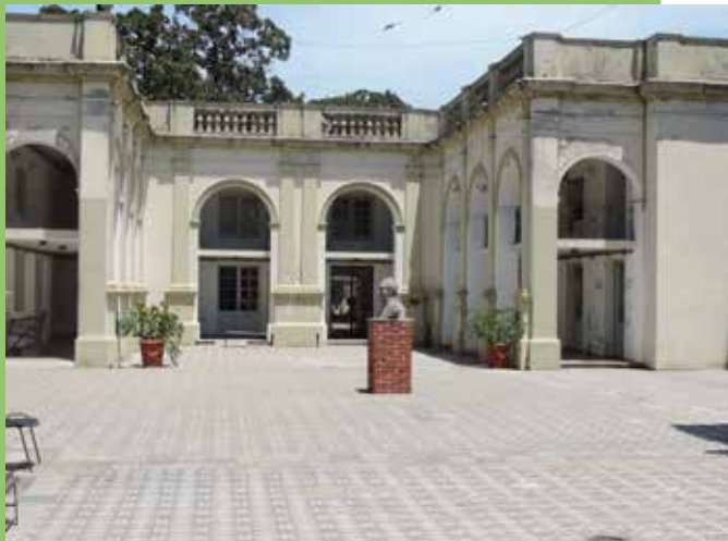
Patio central. Hospital Vilardebó. Registro fotográfico del equipo del MNP, visita inspectiva de 9 de octubre de 2017.
