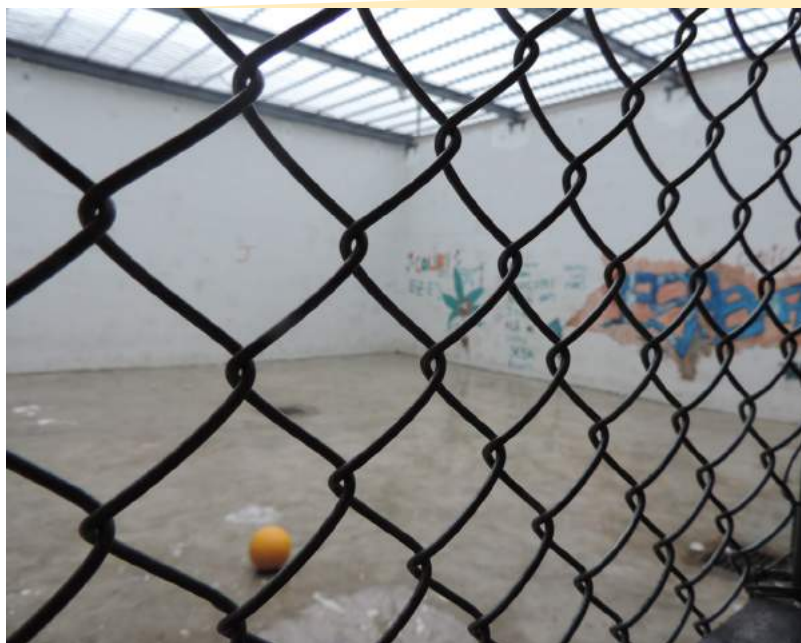
Complejo Belloni, patio. Registro fotográfico equipo MNP.
