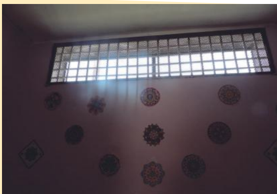
Celda CIAF. Registro fotográfico equipo MNP.
