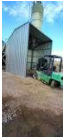
Fig.17 Vista del cerramiento de la zona de carga de camiones.
