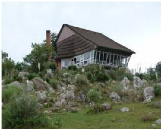
Foto 16 _ Ventorrillo de la Buena Vista
