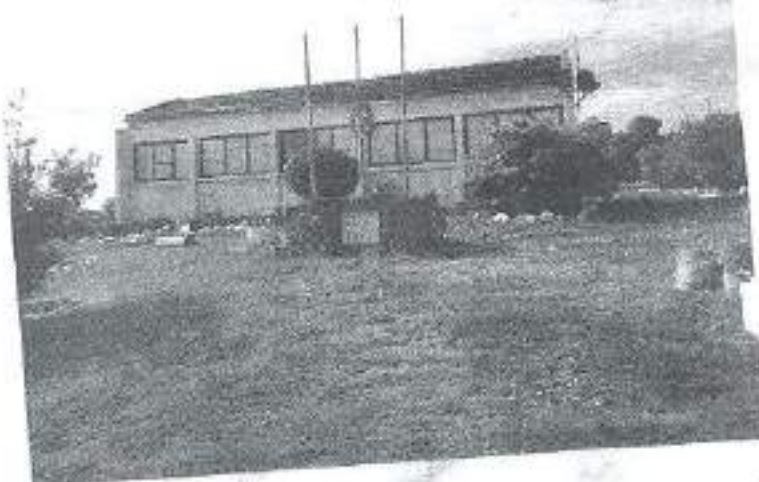
PERFORACIÓN EXISTENTE, FACHADA DE LA CASA DEL MAESTRO
