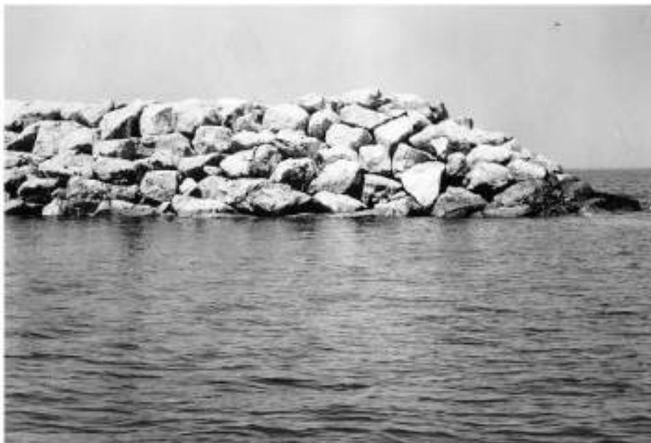
Figura 68 – Ejemplo de enrocado colocado de forma selectiva (Figure VI-4-3 del Coastal Engineering Manual).
