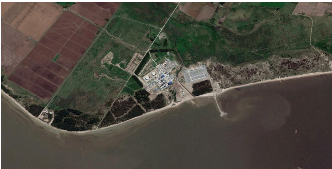
Figura 26. Acumulación de sedimentos en el espigón de una central térmica al oeste de Playa Pascual
