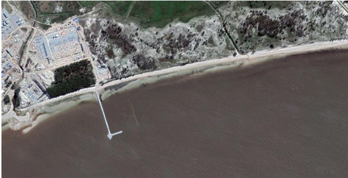
Figura 4. Situación del espigón de la central de Punta del Tigre en 2016 (Fuente: Google Earth).
