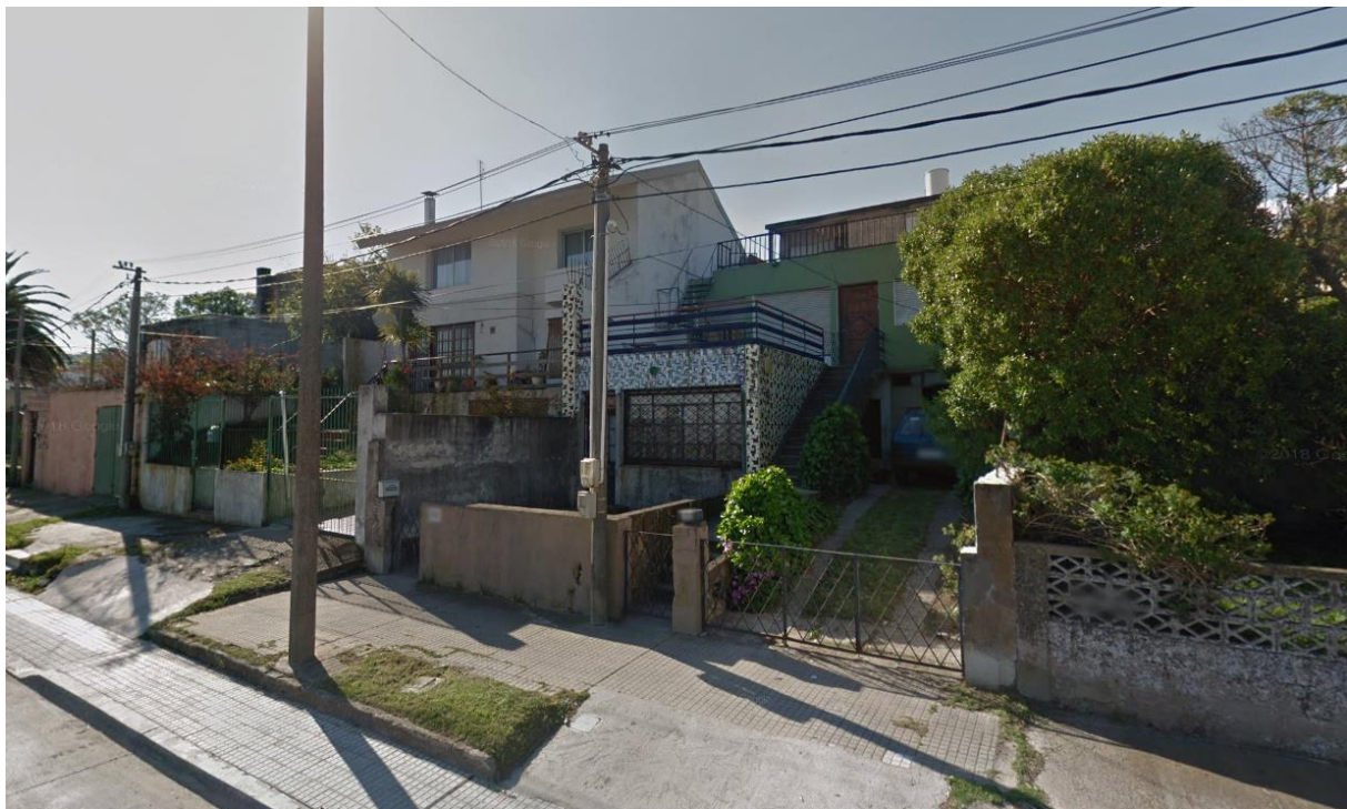
Figura 11. Ejemplo de edificación existente en la zona de Playa del Cerro.
