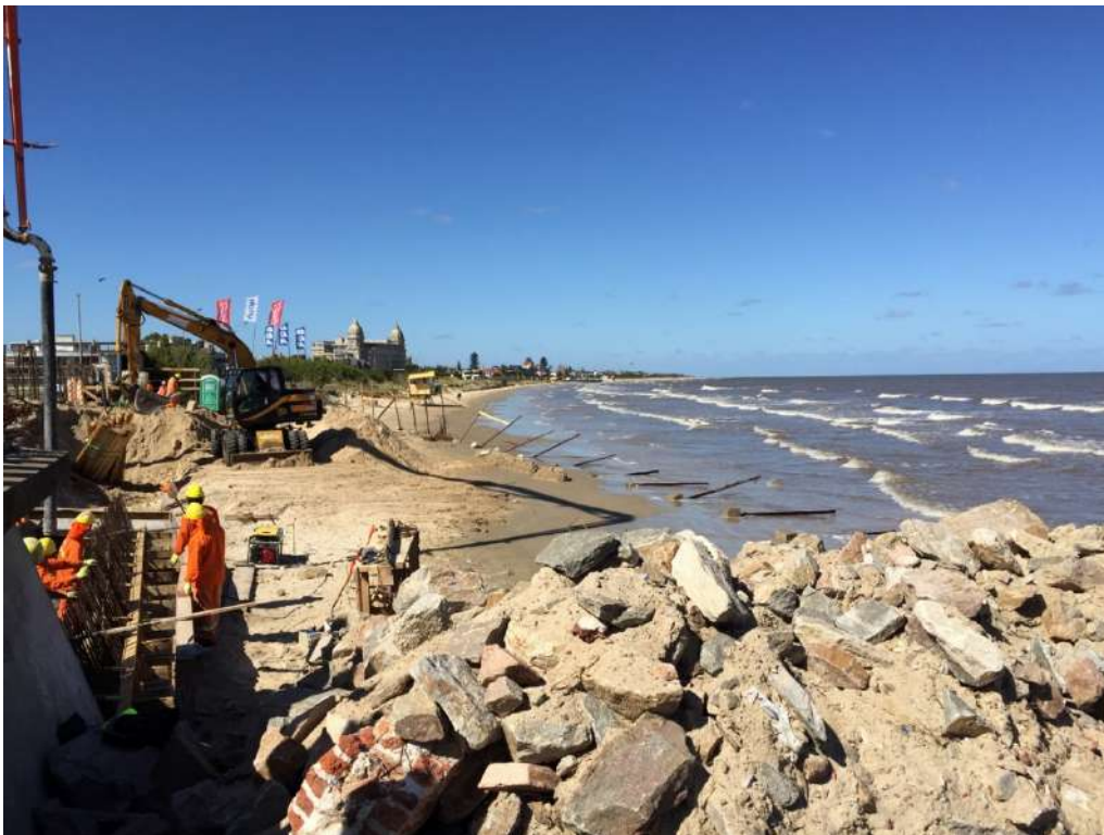
Figura 4. Reparación del muro de protección de la rambla de Montevideo debido a los daños sufridos por la erosión. Detalle de la construcción de un nuevo muro de hormigón. Área de Carrasco.
