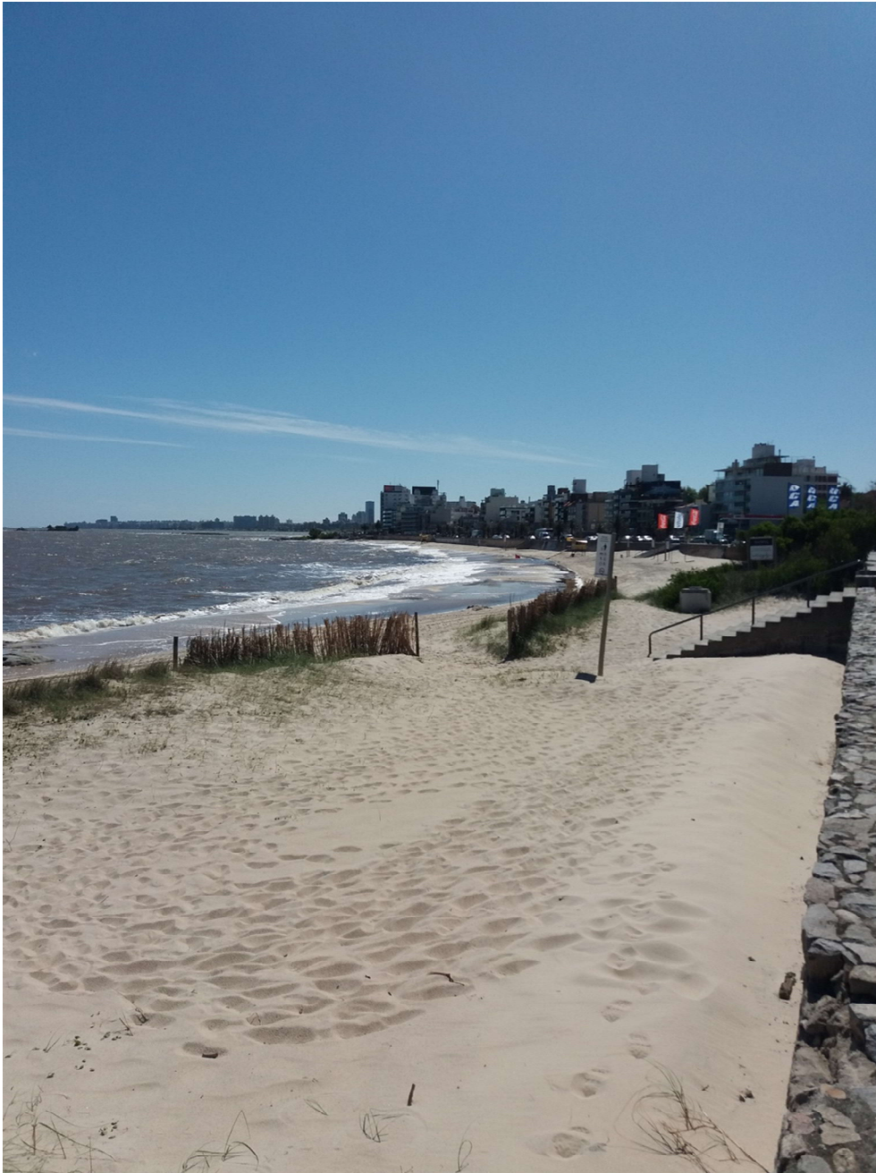
Figura 2. Construcción de cercas para atrapar sedimento.
