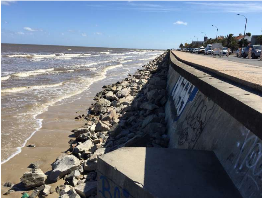
Figura 5. Protección del dique vertical de la rambla de Montevideo mediante un escollero para evitar problemas de erosión. Área de Carrasco.
