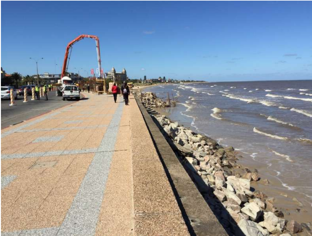
Figura 3. Reparación del muro de protección de la rambla de Montevideo debido a los daños sufridos por la erosión. Área de Carrasco.
