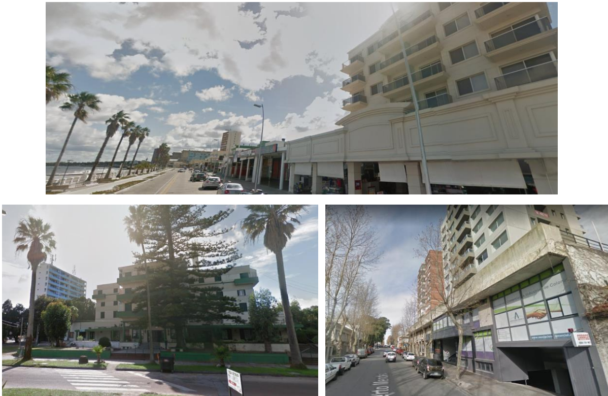
Figura 16. Edificaciones de distintos puntos de la costa uruguaya. En la imagen superior, la zona de Piriápolis. En la imagen inferior izquierda, Atlántida. En la imagen inferior derecha, Colonia (Fuente: Google Maps).
