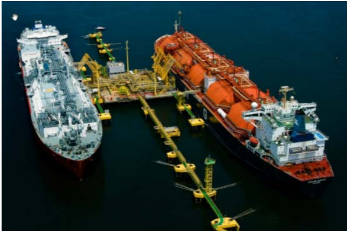
Figura 3–9 Transferencia de GNL mediante brazos de carga
