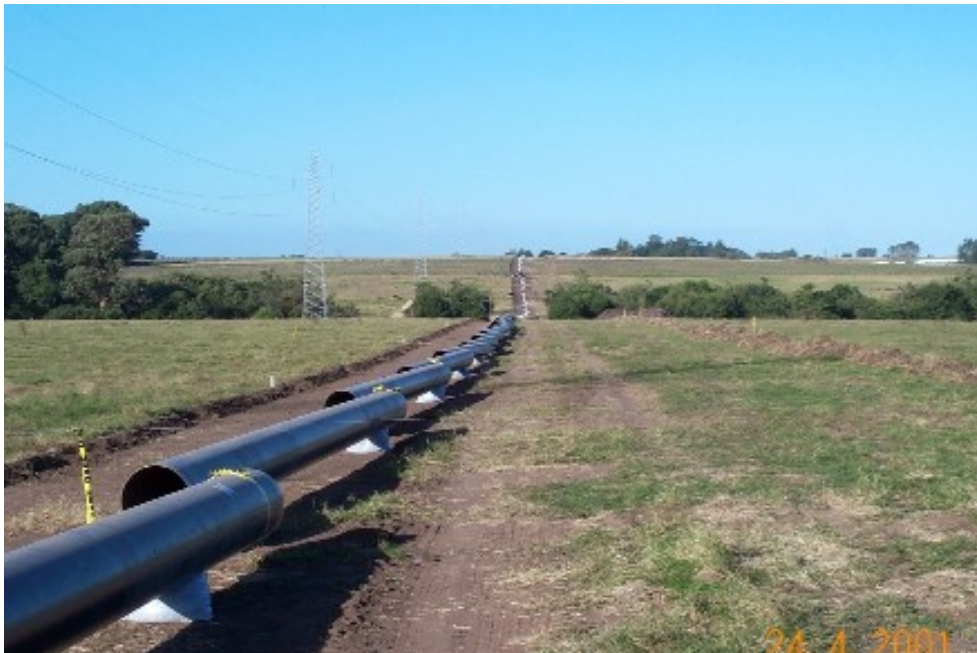
Fotografía 3–4 Distribución de tubos del gasoducto terrestre en la pista
