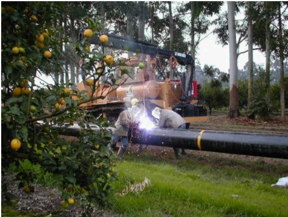
Fotografía 3–5 Vista de soldadura en obra del gasoducto Cruz del Sur
