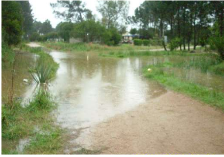
Fotografía 1 _ desbordes sistema actual
