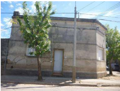
Vivienda Sector D_ Grietas en muros
