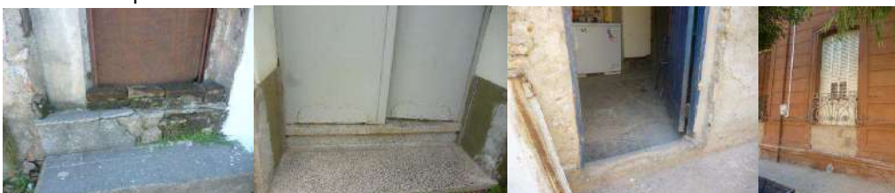
Elevación de antepedechos y esclusas en puertas
