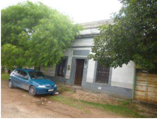
Padrón 3237 - Manzana 517 Año 2015: h. máx.: 1.05 m sobre nivel vereda Año 2019: Agua no entró en la vivienda.
