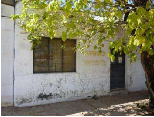
Vivienda Sector C_ Grietas en muros
