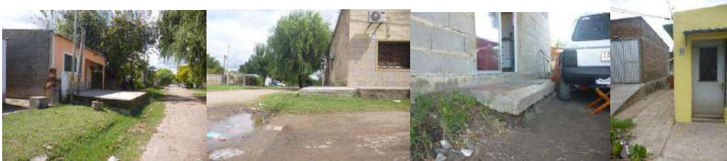
Elevación de pisos exterior
