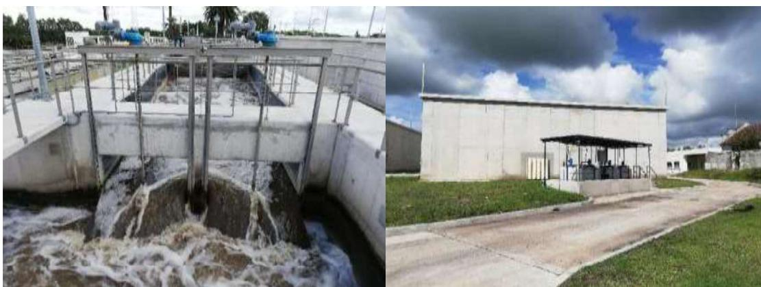
Figura 2-6: Izquierda: Canal de mezcla con cambio de pendiente para sedimentadores horizontales. Derecha: contactores de CAP.
