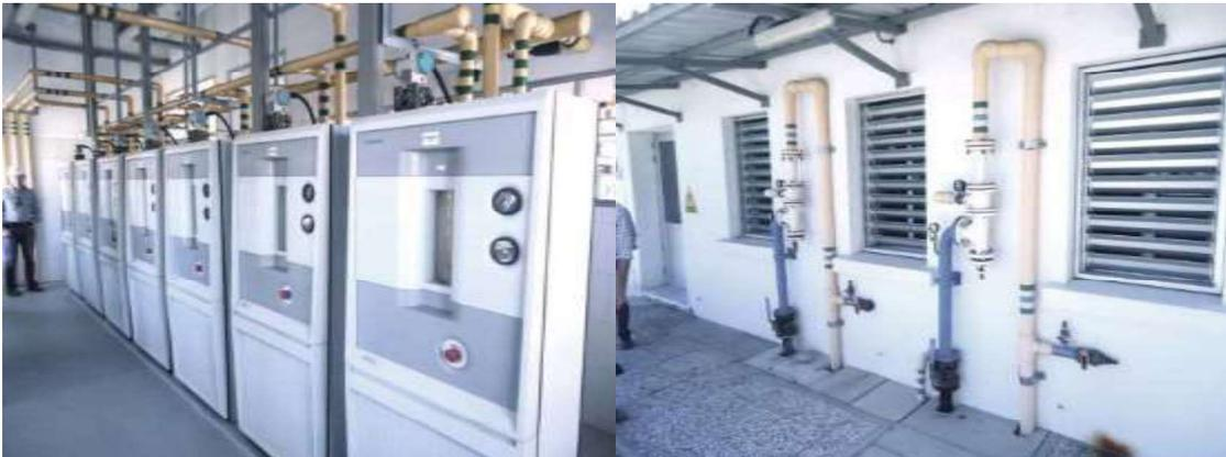
Figura 2-11: Sistema de cloración: Sala de Cloradores (izquierda) y Eyectores de Intercloración (derecha).
