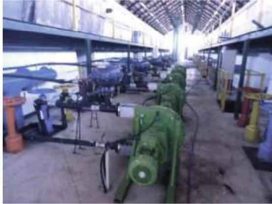
Figura 2-16: Sistema de dosificación de CAP: bombas peristálticas de dosificación.
