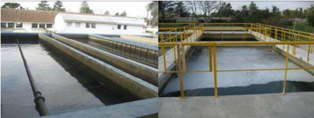
Figura 2-8: Izquierda: Filtros de manto único. Derecha: Filtros bicapa.
