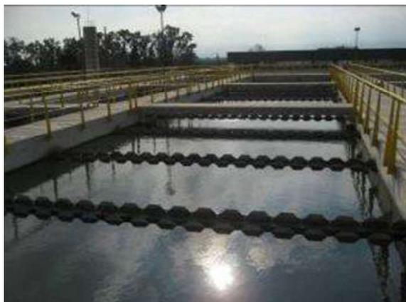
Figura 2-7: Floccodecantadores de alta tasa.
