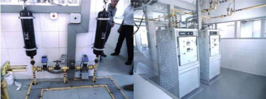
Figura 2-10: Sistema de cloración: Sistema change over (izquierda) y Evaporadores (derecha).
