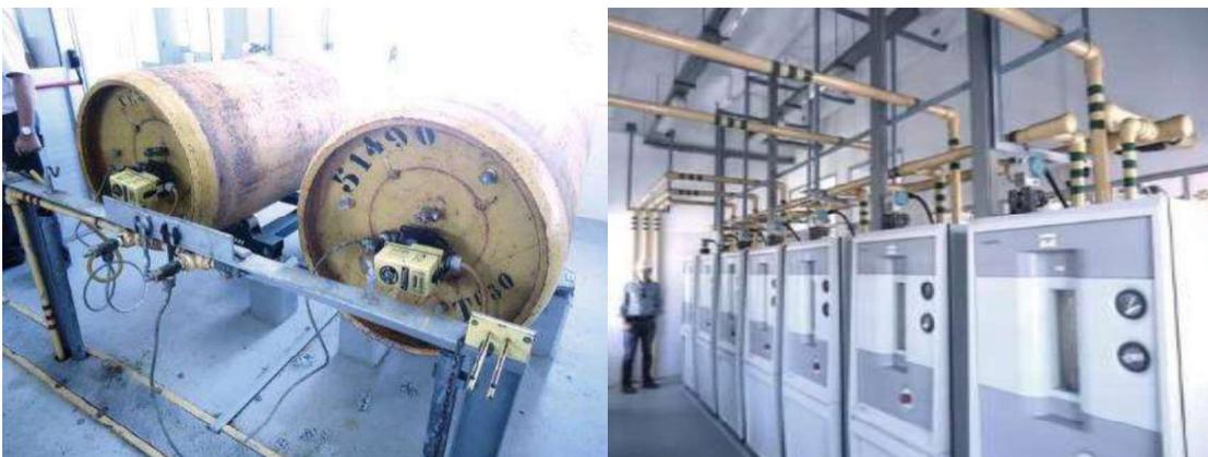
Figura 2-9: Sistema de cloración: Ton containers en uso (izquierda) y Cloradores (derecha).
