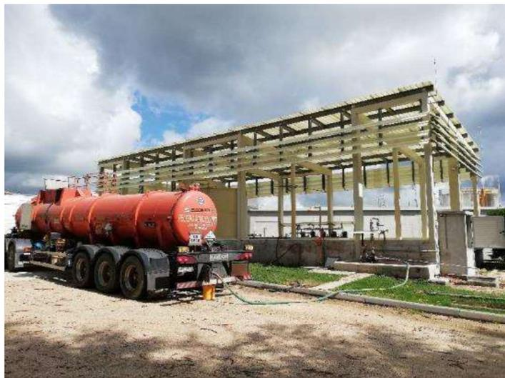
Figura 2-14: Sistema de acopio y dosificación de ácido sulfúrico.
