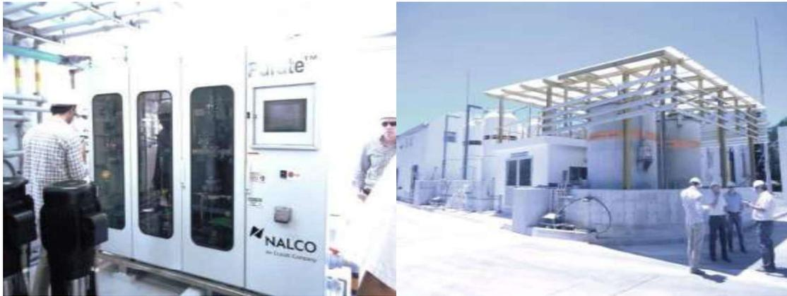
Figura 2-13: Sistema de dosificación de dióxido de cloro. Izquierda: equipos de generación, Derecha: silos de acopio de ácido sulfúrico.
