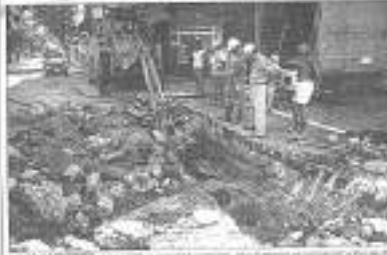
MAJAS UNIVERCEL. El día 27 de julio se suspendió el suministro de agua en el barrio de Majadas por reparaciones en las tuberías.
