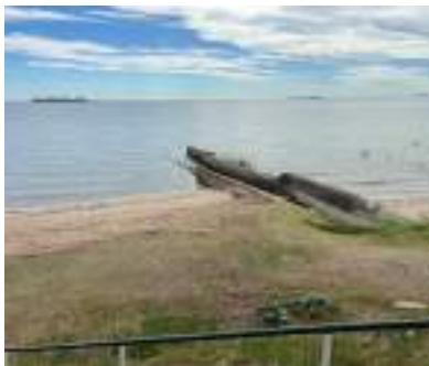
Pluvial en mal estado (Playa El Álamo)
