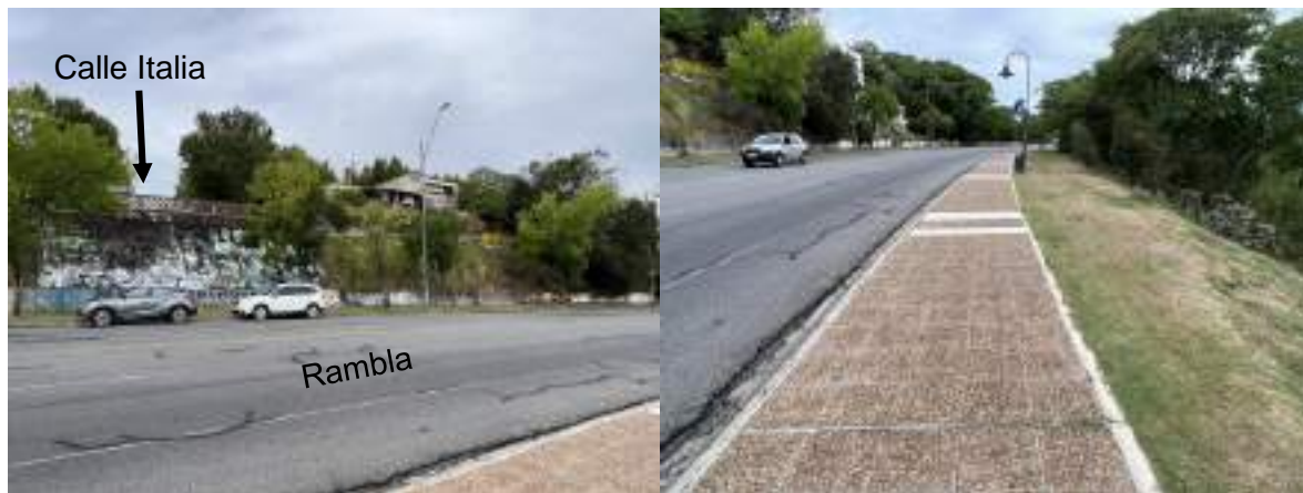
Figura 4-51: Fotografías tomadas en la visita a sitio, en la zona donde el personal de la Intendencia constata la problemática de erosión del talud (Rambla y calle Italia).
