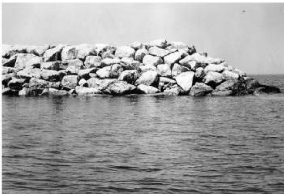
Figura 4-73 Ejemplo de enrocado colocado de forma selectiva (Figure VI-4-3 del Coastal Engineering Manual).
