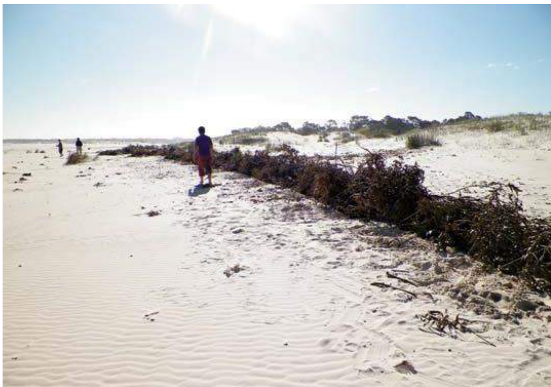
Figura 4-85: Cercas captoras de material biodegradable (tomado de ficha técnica n°6 proyecto URU/07/2013)
