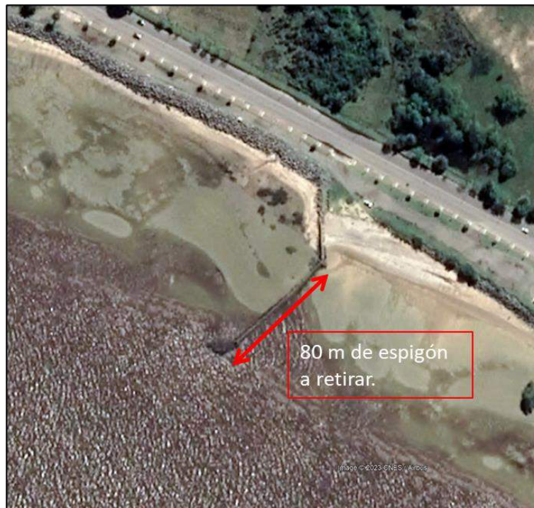
Figura 4-76 Tramo del espigón a retirar.
