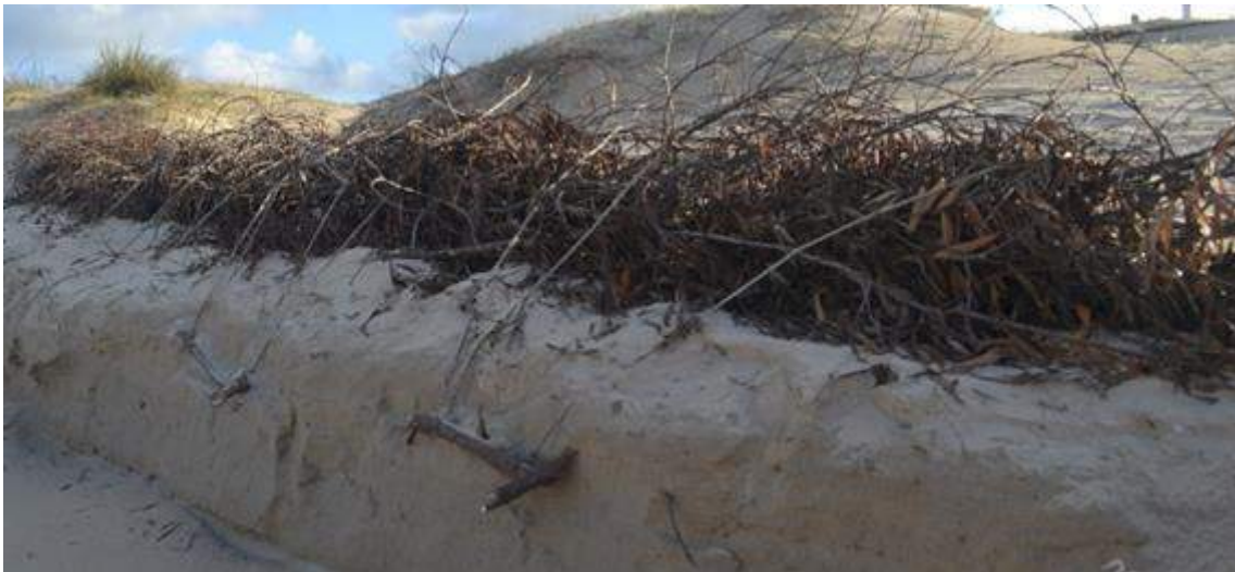
Figura 4-88: Corte de duna recuperada en experiencias anteriormente documentadas donde se aprecian anclajes y ataduras con hilo sisal.
