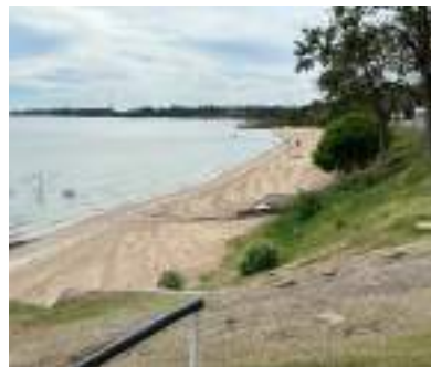
Descarga del pluvial que atraviesa la cancha del Club Juventus (playa El Álamo). La Rambla está a por lo menos 4 metros por arriba del nivel de la cancha.
