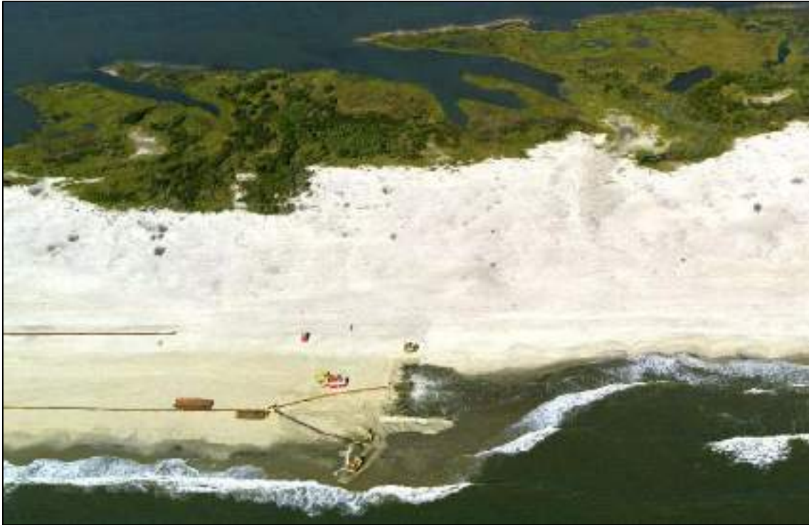
Figura 4-68 Ejemplo de proceso constructivo de relleno de playas (tomado de https://www.nps.gov/articles/beach-nourishment.htm ).
