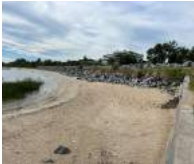
Protección (entre calle Mauricio Cravotto y Francisco Soca)
