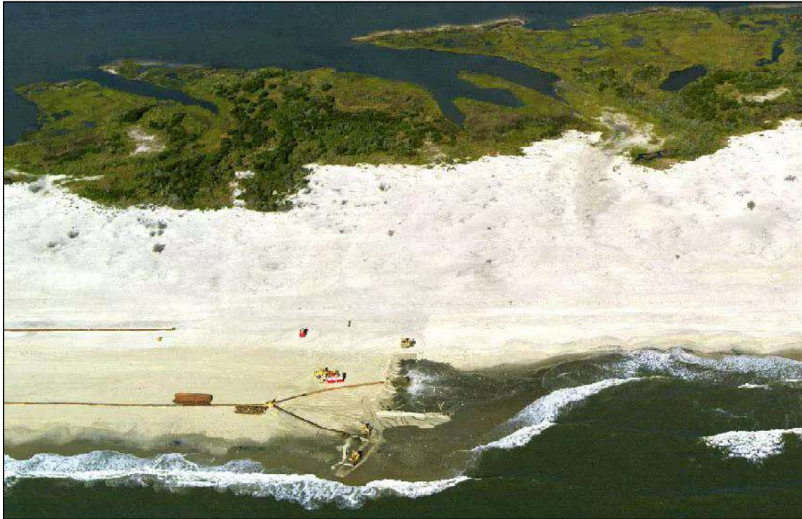
Figura 4-77 – Ejemplo de proceso constructivo de relleno de playas (tomado de https://www.nps.gov/articles/beach-nourishment.htm ).
