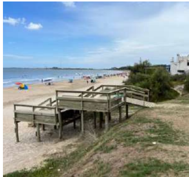
Estructura de acceso a la playa y vivienda sobre primera línea de costa
