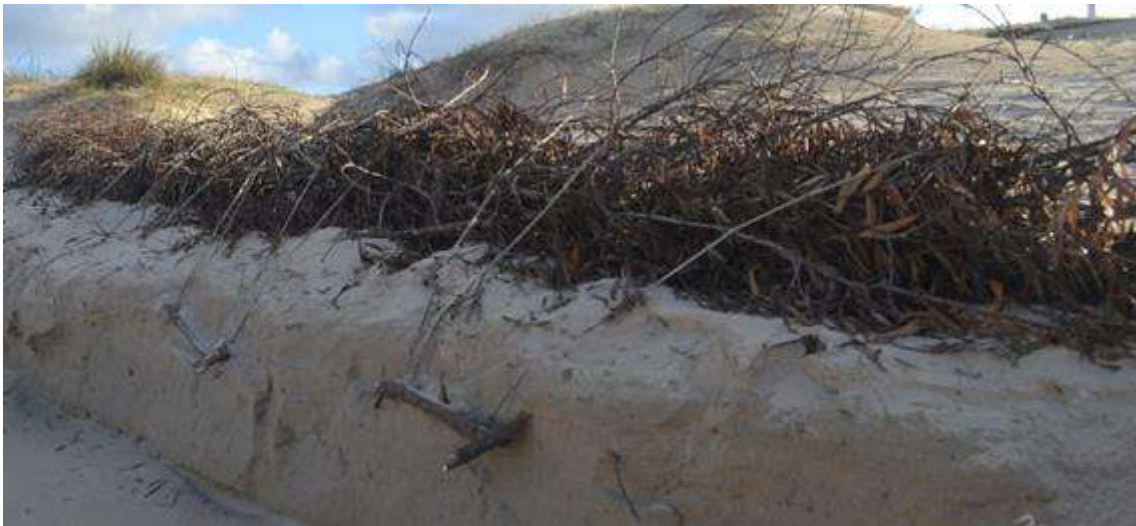
Figura 4-85. Corte de duna recuperada en experiencias anteriormente documentadas donde se aprecian anclajes y ataduras con hilo sisal.
