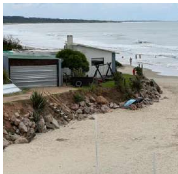
Vivienda en Costa Azul en zona con problemas de erosión. Límite norte de la zona de estudio (esta zona no está incluida en este estudio).
