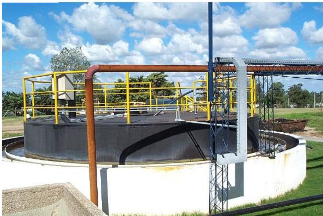
Figura 25 – Fotografía del primer reactor UASB de MOSA. Fuente: López et al. (2019)
