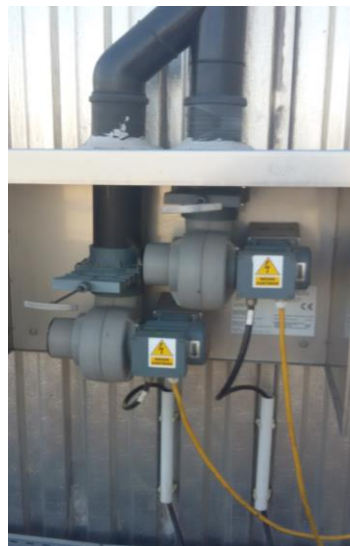
Figura A4- Ventiladores para inflado de techo del biodigestor Weltec, Estancias del Lago
