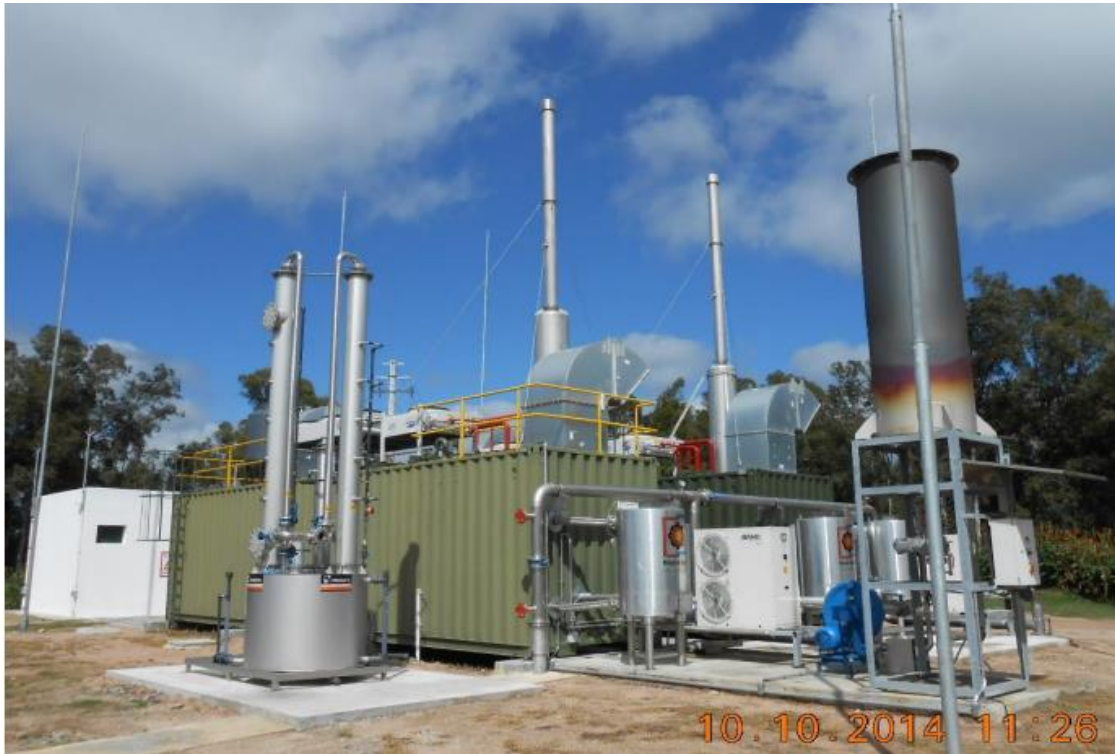
Figura 23 – Acondicionamiento de biogás, antorcha y CHPs. Fuente: Hernández (2017)
