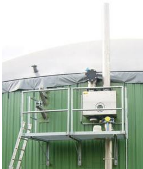
Figura A8– Válvula de seguridad para biodigestores con techo de membrana
