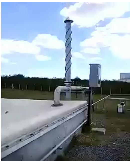
Figura 4 – Tubería de salida de biogás y chimenea de venteo
