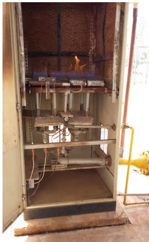
Figura 27 – Vista interior del quemador de biogás en MOSA (se retiró cubierta aislante delantera). Fuente: Fotografía del autor, con autorización de MOSA. Fecha: 6/11/2020
