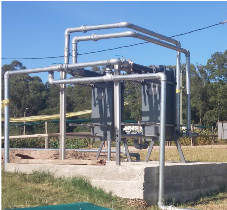
Figura 20 – Reactor anaerobio de Lanas Trinidad. Intercambiadores de calor externos Fuente: Fotografía del autor, con autorización de Lanas Trinidad S.A. Fecha: 15/03/2019
