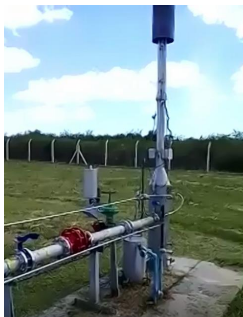
Figura 5 – Antorcha de biogás con arrestallama y sistema de encendido
