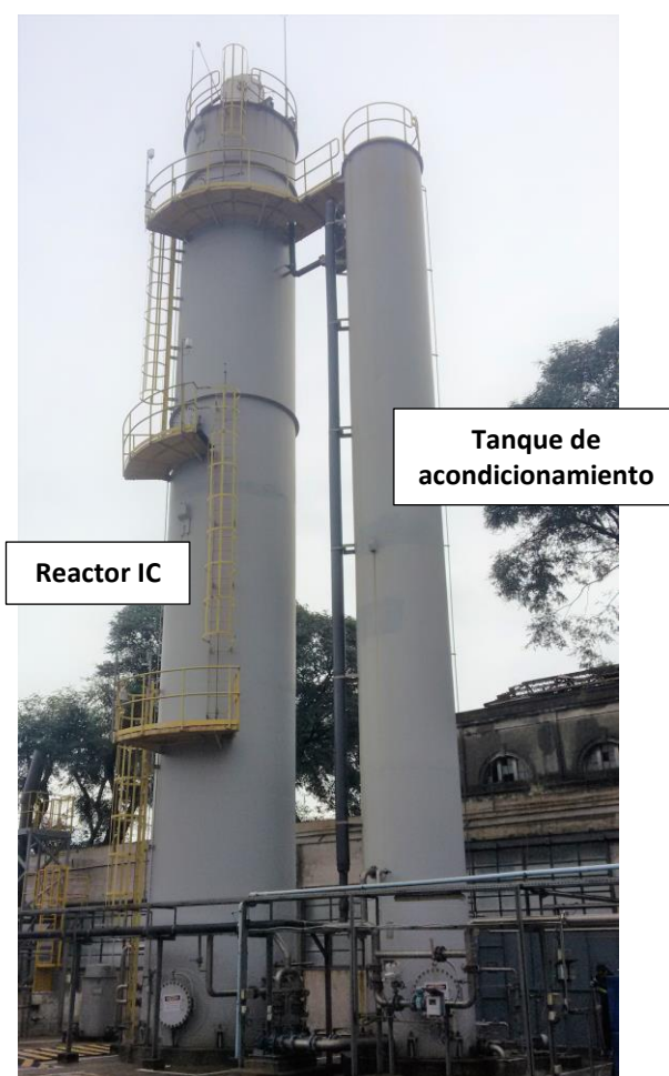
Figura 13 – Reactor anaerobio BIOPAQ® IC y tanque de acondicionamiento en FNC Montevideo Fuente: fotografía tomada por el autor, con autorización de FNC. Fecha: 19/05/2017
