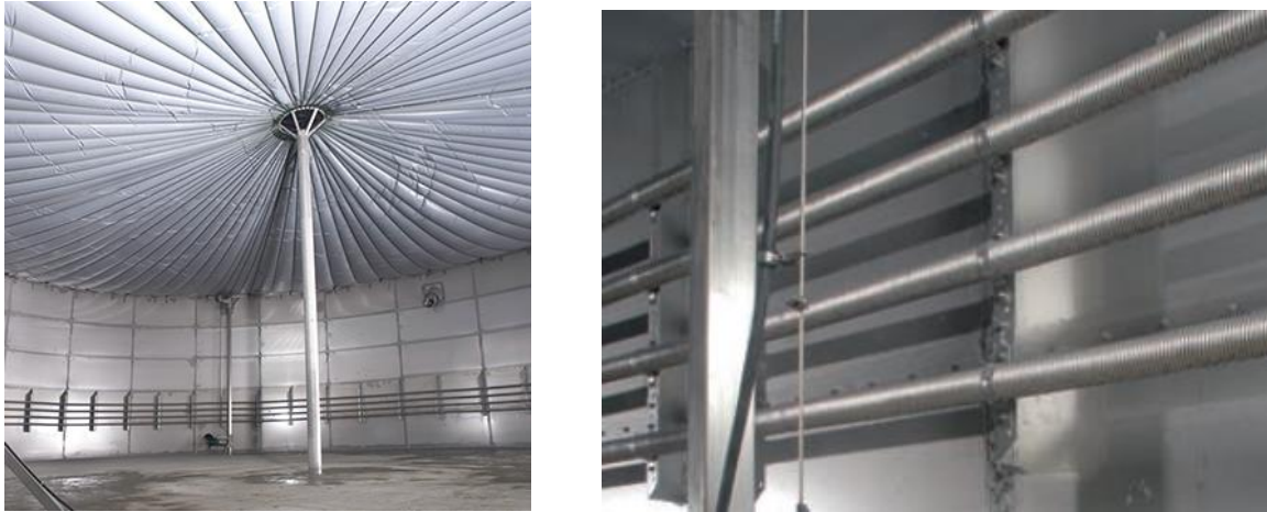
Figura A7 – A la izquierda, vista interior de un biodigestor Weltec, con la tubería de calefacción, y el soporte de la cubierta interior. A la derecha, detalle de la tubería de calefacción
