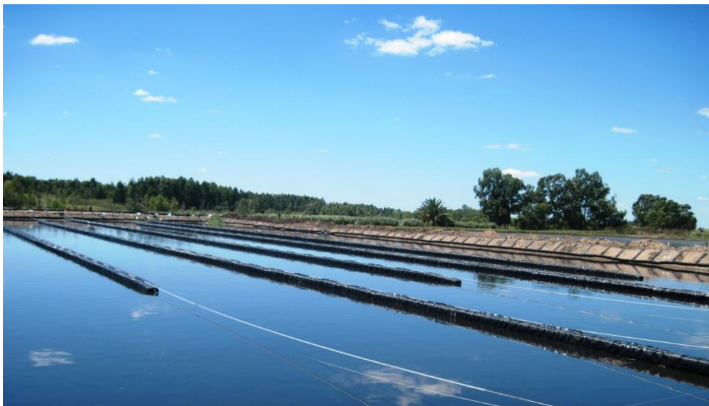
Figura 18 – Colocación de mamparas flotantes (previo a instalar la cubierta) Fuente: Hernández (2017)
