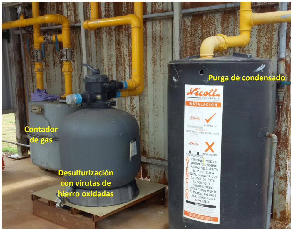
Figura 26 – Acondicionamiento de biogás en MOSA. Fuente: Fotografía del autor, con autorización de MOSA. Fecha: 6/11/2020
