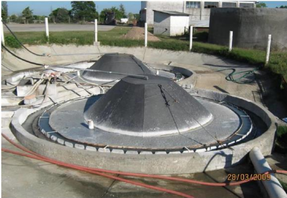
Figura 11 – Vista de reactores UASB de COLEME. Fuente: López et al. (2019)
