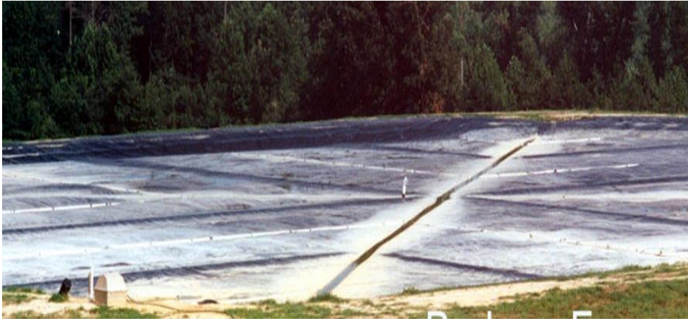
Figura 6 – Ejemplo de cubierta flotante (Fuente: www.rcmdigesters.com )
