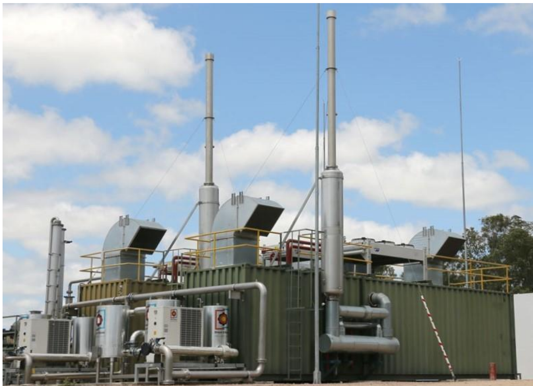
Figura 16 – Ejemplo planta de cogeneración con biogás (Fotografía gentileza de Lanás Trinidad S.A.)
