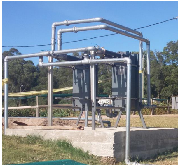
Figura 10 – Intercambiadores de calor externos (Fuente: Fotografía del autor, con autorización de Lanas Trinidad S.A.)
