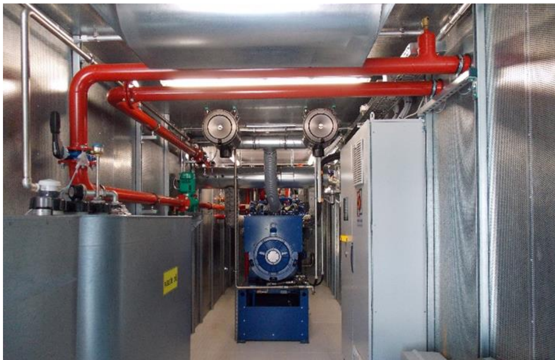
Figura 18 – Ejemplo de unidad de cogeneración (“CHP”) con biogás (Fotografía gentileza de Lanas Trinidad S.A.)
