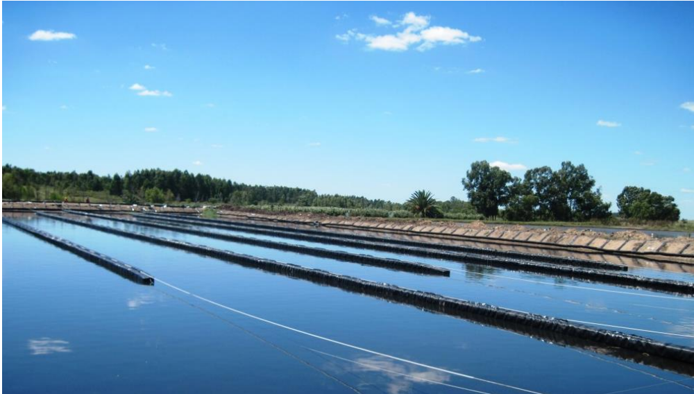
Figura 9 – Mamparas flotantes instaladas (Fotografía del autor, con autorización de Lanas Trinidad S.A.)
