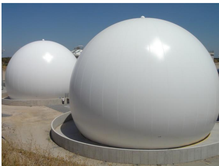
Figura 12 – Gasómetros autónomos de doble membrana (Fuente: https://ceno.sattler.com/es/gasspeicherung )
