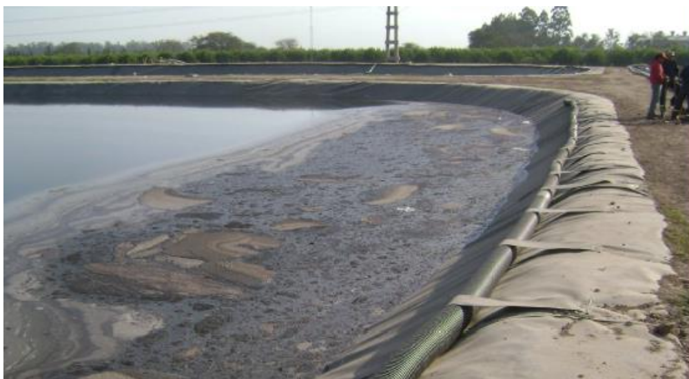
Figura 5 – Tubería perimetral de captación de gas (Fotografía gentileza SIGSA).
